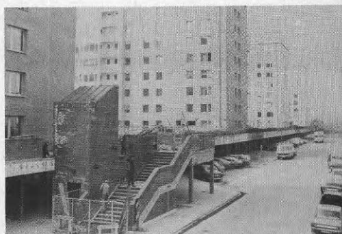
Fig. A.6. Byggnad av gårdstrappa vid Sörbäcksgatan.
