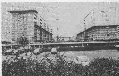
Fig. A.5. Ombyggnad av två höghus har påbörjats.
