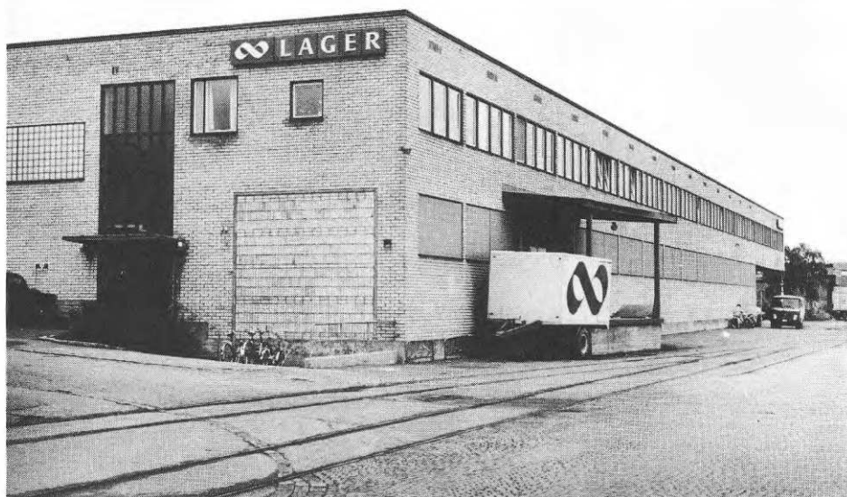
Fig. 23. Vy av lagerbyggnad.
