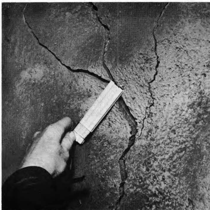
Fig. 16. Spricka i sprutbetong.
