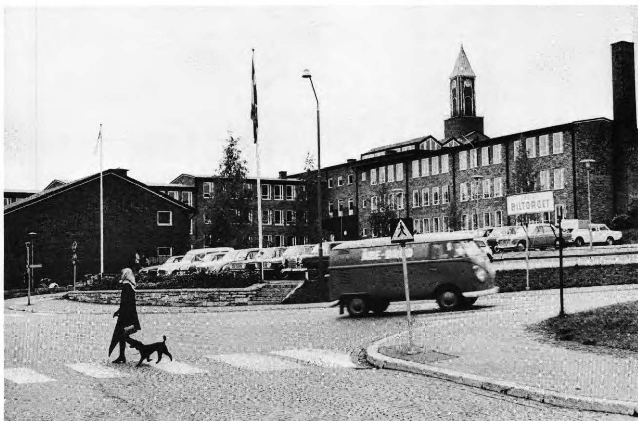
Fig. 8. Vy över objekt 13 och 12, Österängsskolan och Nya kyrkan där de första skadorna p.g.a. skiffersvällning konstaterades.
