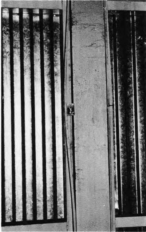
Fig. 25. Detalj av bucklad stålprofil.
