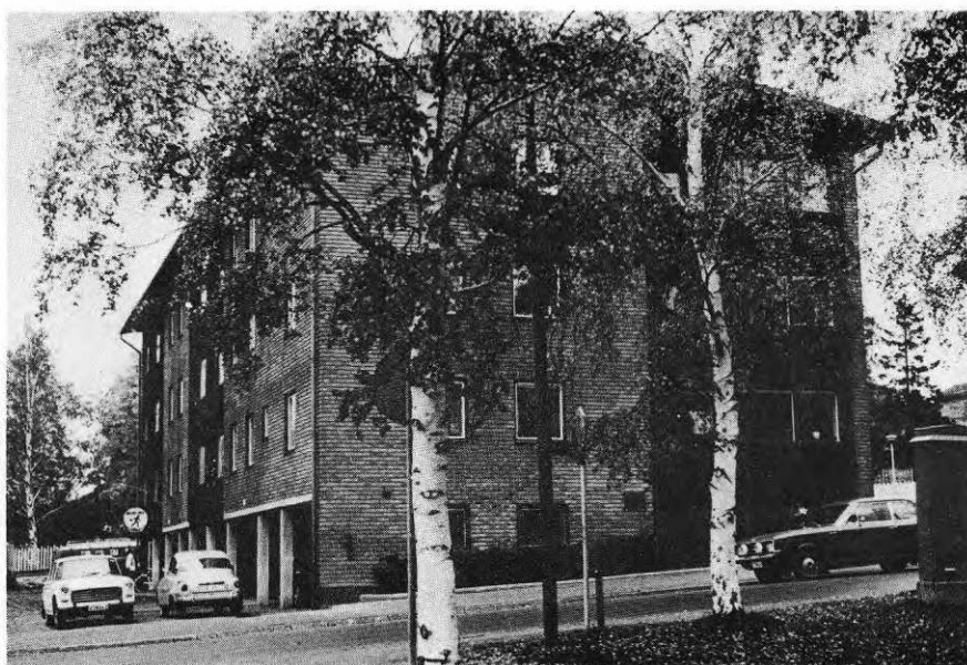
Fig. 2. Byggnad med bowlinghall i källarvåningen.
