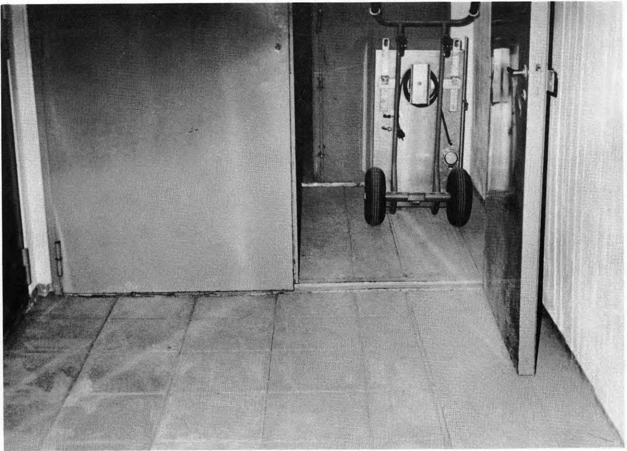
Fig. 28. Betongplattor på sandbädd.
