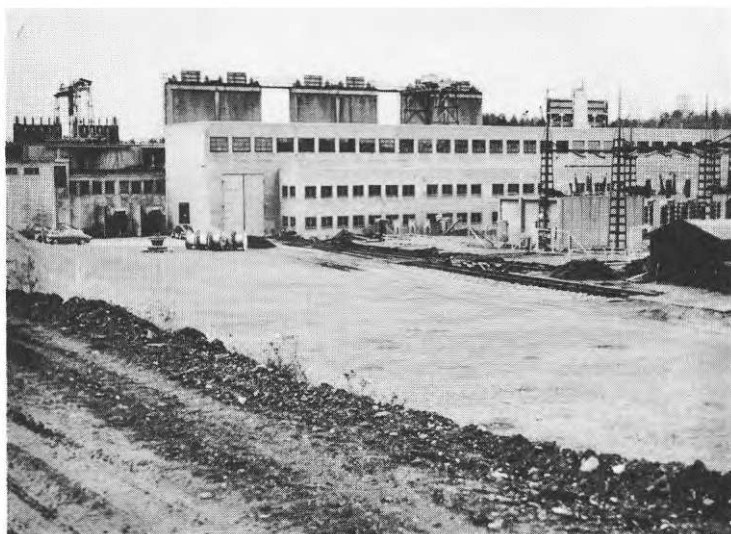
Fig. 14. Nedströmsvy av Hissmofors kraftverk. Längst till vänster syns en del av det gamla kraftverket från början av 1900-talet.
