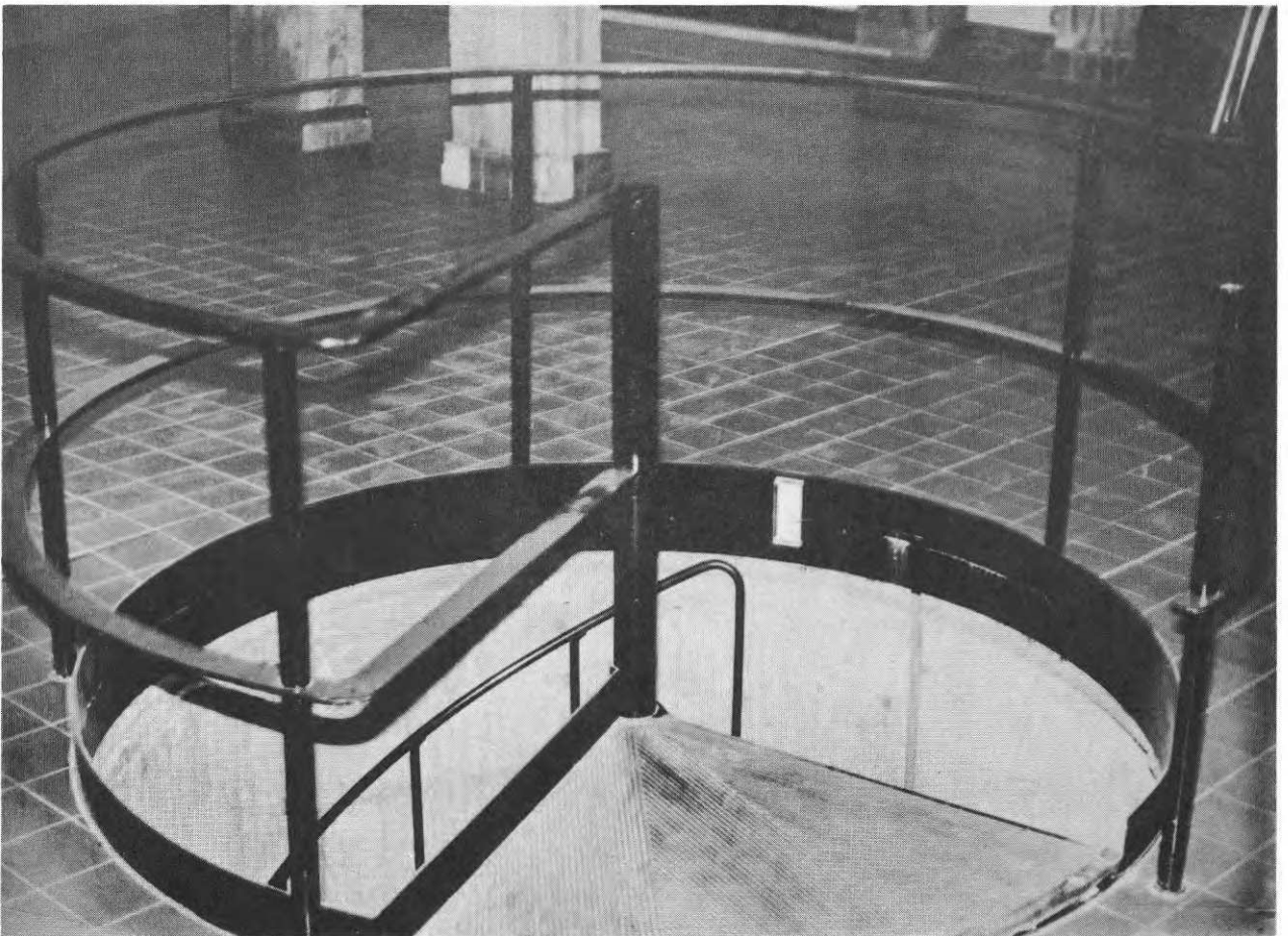
Fig. 20. Spiraltrappa i maskinsal med övre delen av mätanordning.
