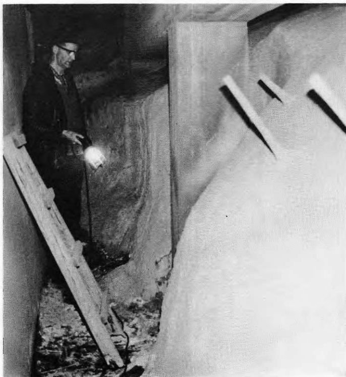
Fig. 15. Skifferytan täckt med sprutbetong.
