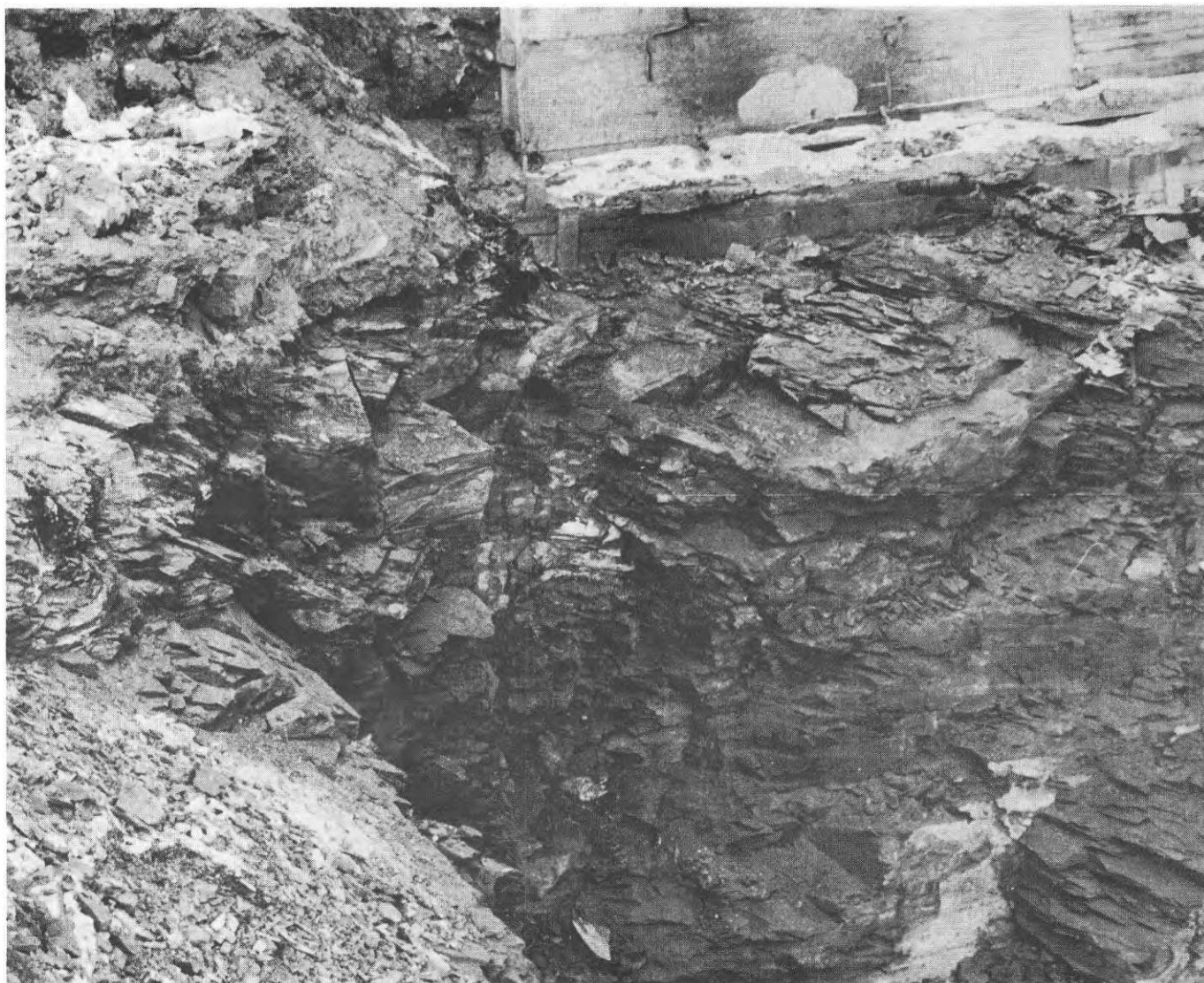
Fig. 14. Schakt i skifferberg.
