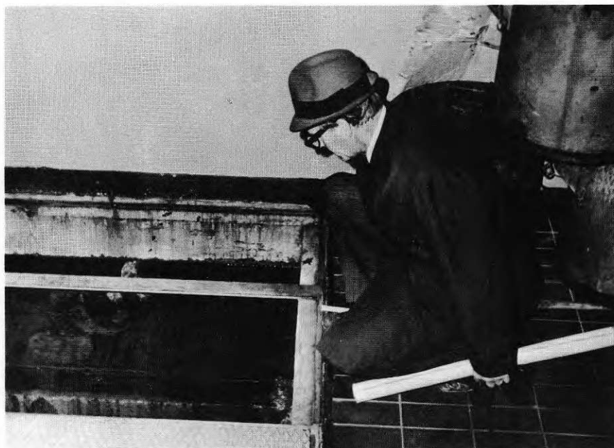
Fig. 9. Pumpgrop med vattentröskel.
