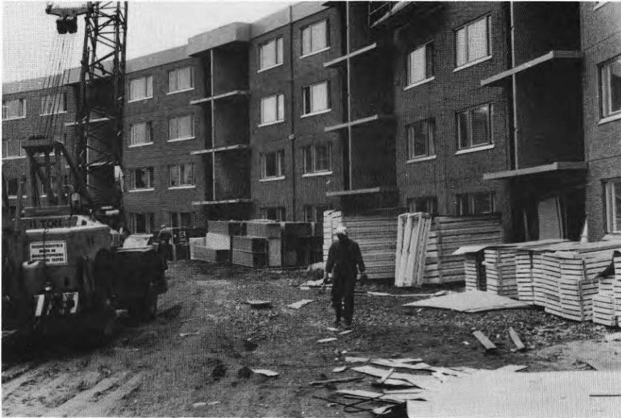
BILD 1. Transportsystemet ställer krav på goda utrymmesförhållanden. På denna arbetsplats har upplagen placerats i väl samlade grupper nära huslängorna. Markens fasthet och vägens bredd gör det möjligt för en stor lastbil att passera kranen.
