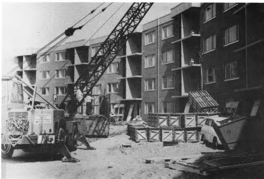
BILD 2. Mobilkran i färd med att lossa kylskåp. Det medför ofta längre väntetid att köra fram en mobilkran till lossningsplatsen än om spårburen kran används. Å andra sidan är det en stor fördel att på långsträckta arbetsplatser slippa lägga ut kranspår som hindrar trafiken på arbetsplatsen.
