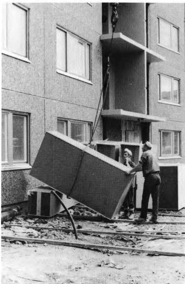
BILD 5. Stora skåp lyfts med kran till bjälklagen var för sig. Små skåp lyfts i korg eller bärs till resp. inmonteringsplats.
