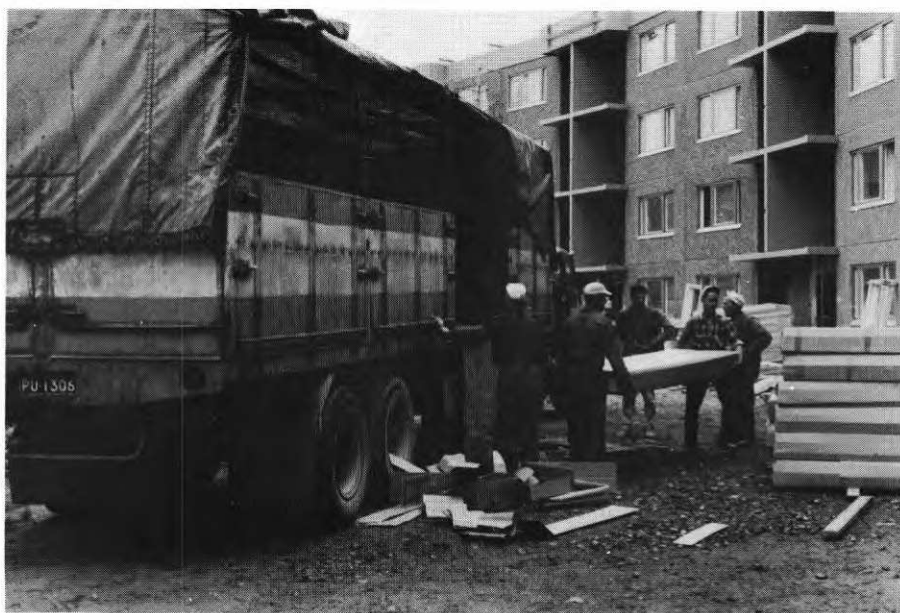
BILD 6. Här lossades dörrar för hand - i och för sig ovanligt på de studerade arbetsplatserna. Förpackningarna innehåller 5 dörrblad, vilket är en mycket tung börda för lossningspersonalen. Så långt möjligt bör manuella och horisontella transporter undvikas på byggarbetsplatsen.
