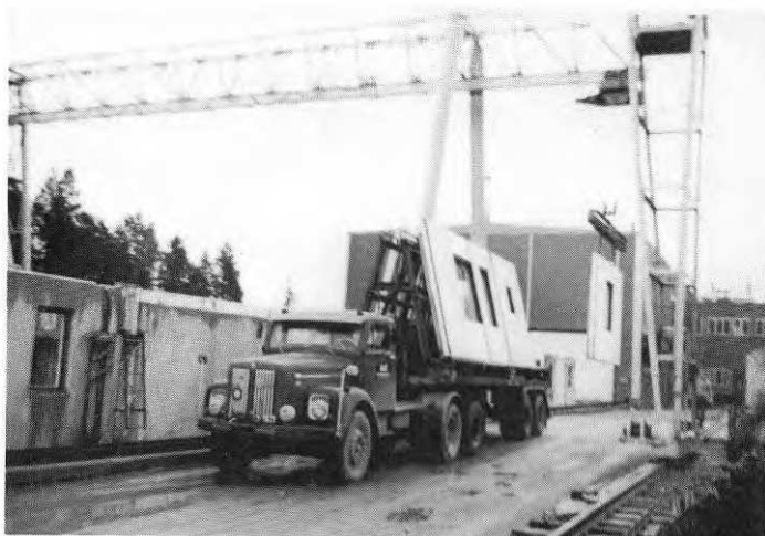
FIG. 31 Hantering och hanteringshjälpmedel på fabrik för a) bjälklag, b) innerväggar och c) fasader.
