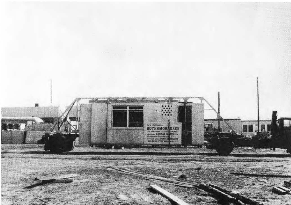
FIG. 11 Västtyskland. Fordon med nedsänkt lastyta för transport av element av gasbetong. (Foto: Triebel, Achterberg, Brocher, 1968)
