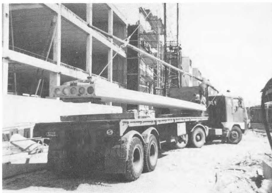
FIG. 46 Lossning av bjälklag på byggplats.
