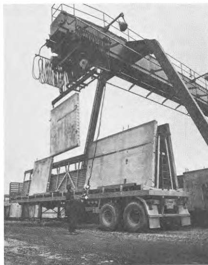
FIG. 3. Lastning av element vid fabrik.
