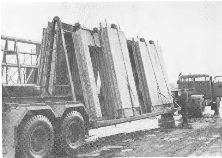
FIG. 5 Sverige. Fordon med nedsänkt lastyta för transport av innerväggs- eller fasadelement. (Foto: Jonsson 1969)
