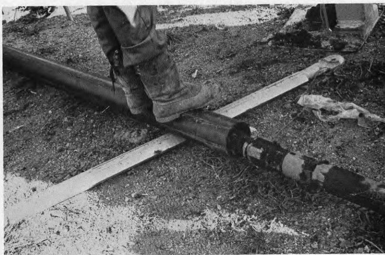
3. Borr med skarvrör sticks in i foderröret.
