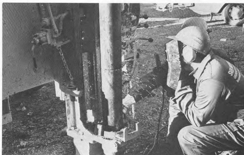
10. Foderröret skarvas vid behov med svetsning.
