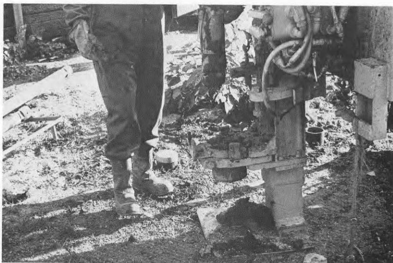
5. Foderrör med borranordningarna under inpassning.
