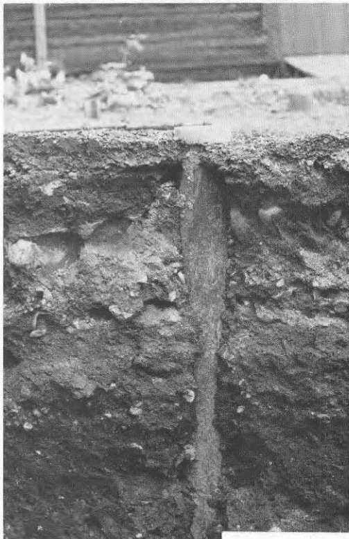
11. Foderrör P3, övre del i närbild.
