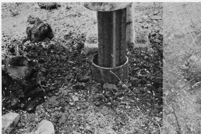
16. Genom foderröret kan slås en stålpåle utan att omkringliggande kulturlager störs.
