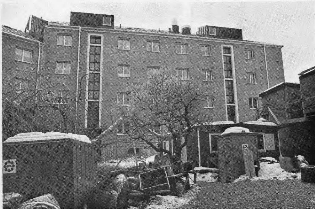
Figur 6.26 Gårdsfasaden efter ombyggnad. Linhissarnas maskinrum på vinden och fläktventilationssystemet har krävt ingrepp i taket
