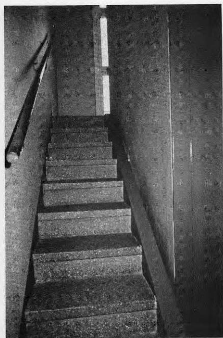
Figur 6.20 Trapploppet är 70 cm brett efter hissinstallationen
