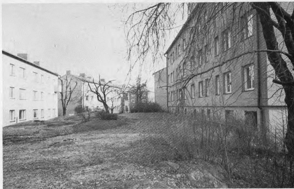
Figur 4.26 Gården mellan husen. Filaren 7 till höger
