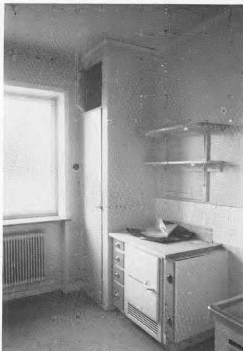
Figur 4.12 Köksinteriör, Jakthunden 4 Friskluftventilerat skafferi och litet kylskåp. Spisen demonterad
