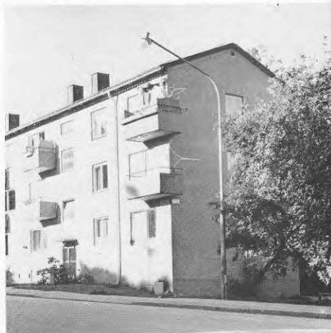
Figur 2.2 Smalare lamellhus finns framförallt i Stockholm, där de är helt dominerande bland de halvgamla flerbostadshusen
