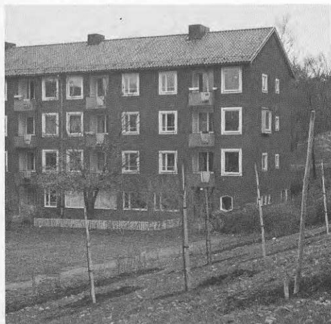
Figur 2.1 Den vanligaste hustypen från 1930-55 är friliggande lamellhus. De flesta är 10-12 m djupa och har 2-4 våningar
