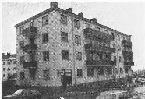
Figur 6.10 Jakthunden 4:s gatufasad före ombyggnad
