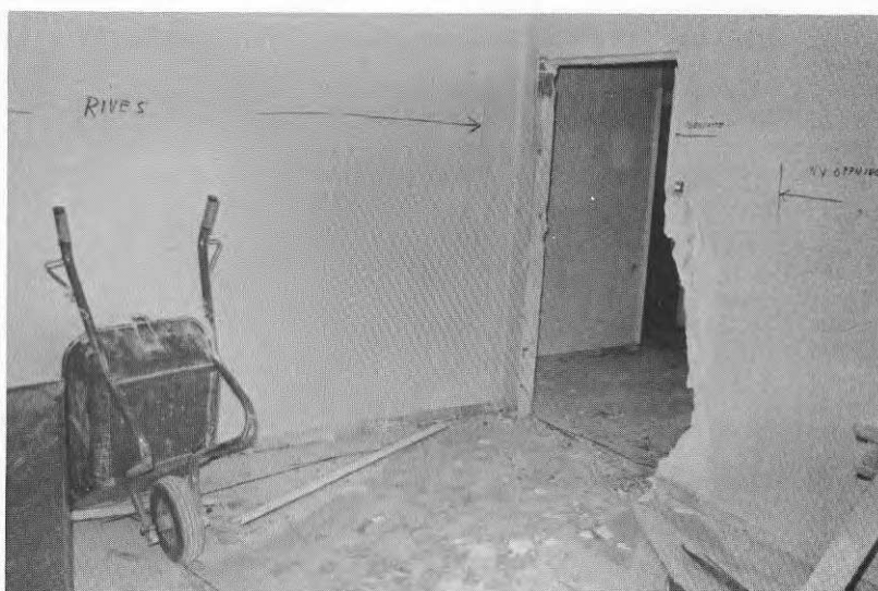
Figur 2.21 Stora ingrepp i en befintlig stomme
