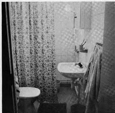
Figur 6.15 Badrum efter ombyggnad. Trots vidgning blir en del badrum ändå trånga
