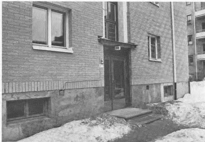
Figur 6.13 Fasaden i figur 6.12 efter ombyggnad med tilläggsisolering
