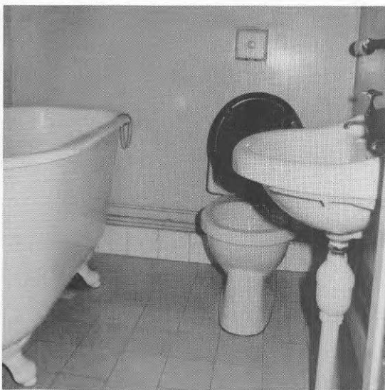
Figur 4.17 Badrum med uteluftventil, Jakthunden 4
