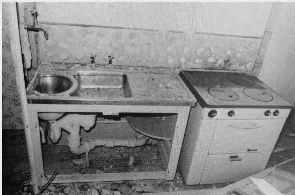
Figur 4.18 Kök under rivning. Rostfri diskbänk utan vattenblandare med separat tappventil över utslagstratt, Jakthunden 4
