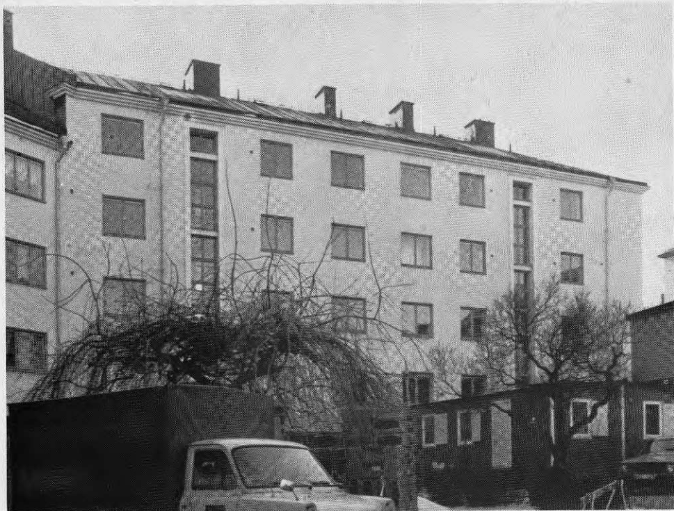
Figur 6.25 Gårdsfasaden före ombyggnad, Jakthunden 4
