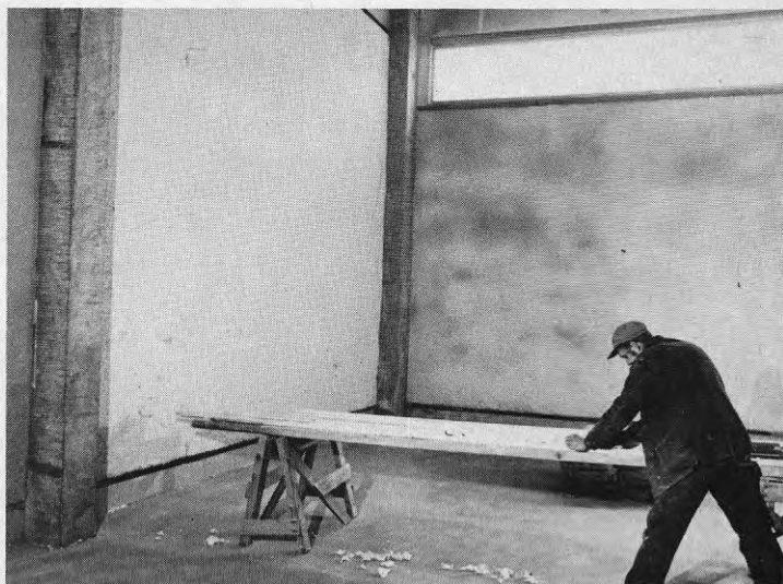
Figur 9.3. Industribyggnad försedd med in- vändig beklädnad av fiberarmerad puts.
