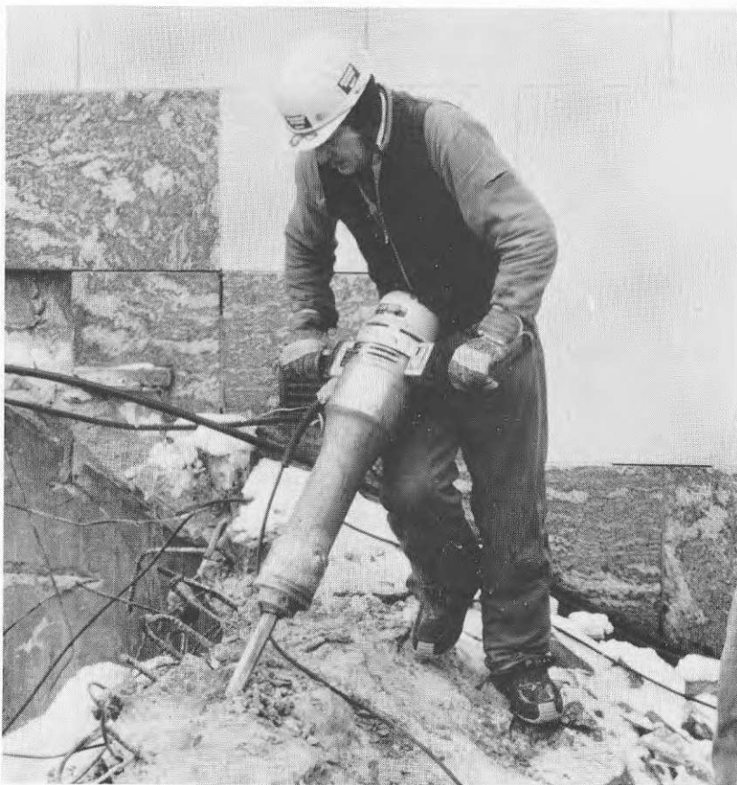
Figur 1. Bilning med handhållna maskiner. Människan fungerar som ett stativ som tar upp maskinens vibrationer.
