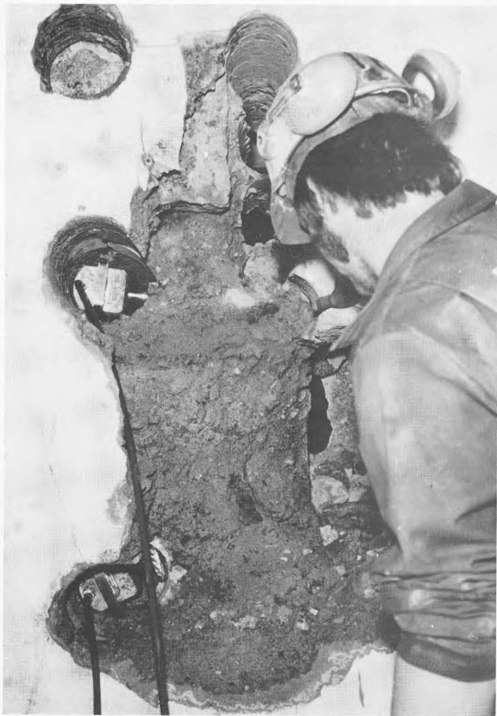
Figur 18 b) Spräckcylindrarna placeras i hålen.
