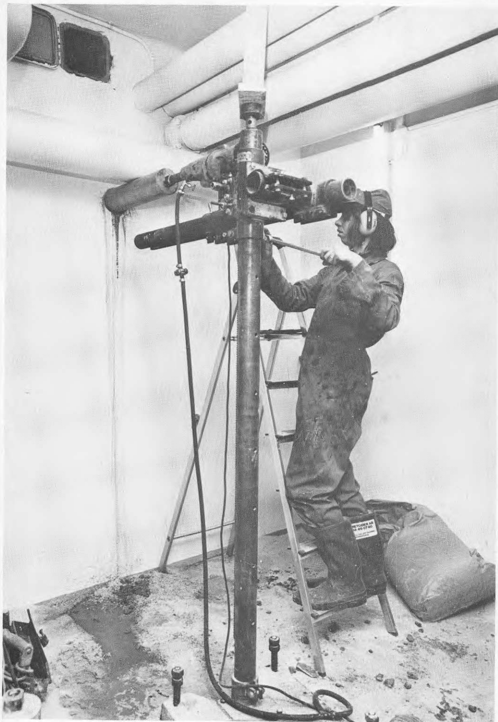
Figur 8. Skärborrning i vägg.
