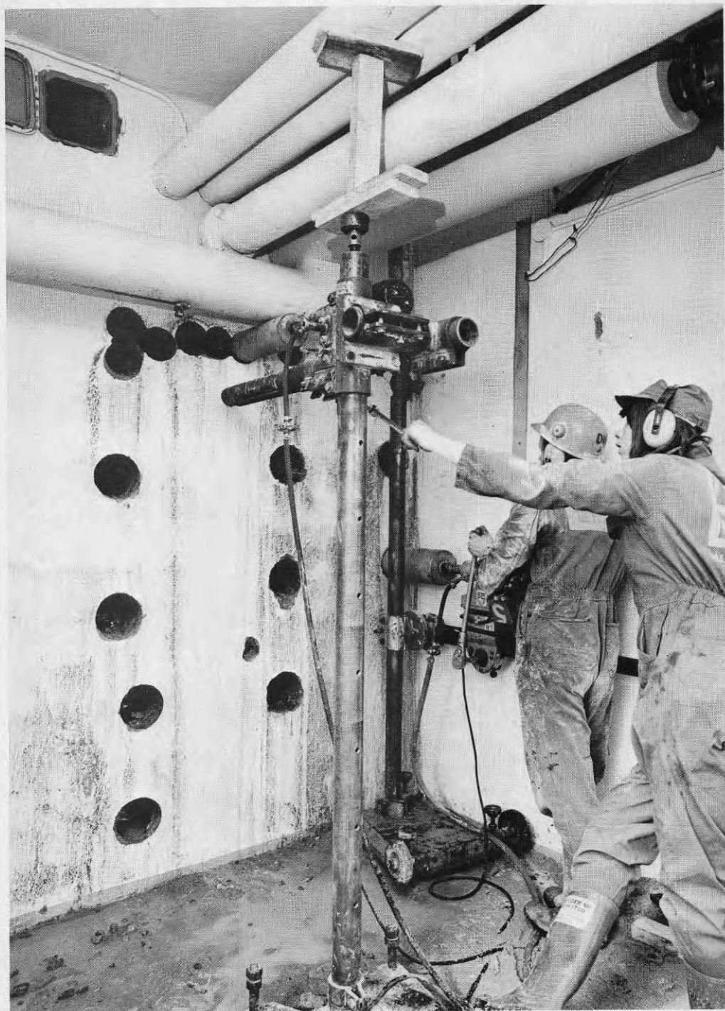
Figur 18. Spräckning med spräckkolvutrustning. a) Hålen för spräckcylindrarna tas upp med hjälp av skärborrning.
