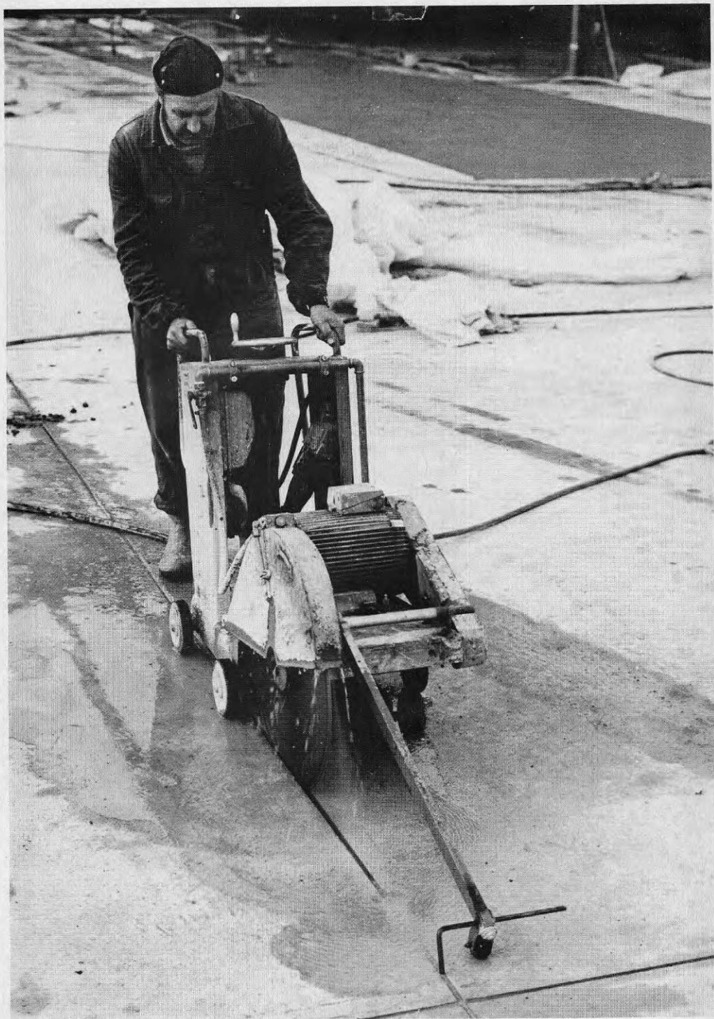
Figur 10. Sågning i valv.
