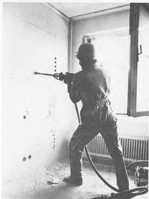
Figur 4. Slagborrning med tryckluftsdreven maskin.
