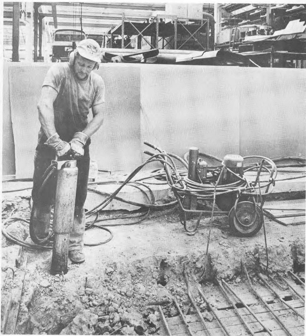
Figur 14. Spräckning med spräckkilutrustning.
