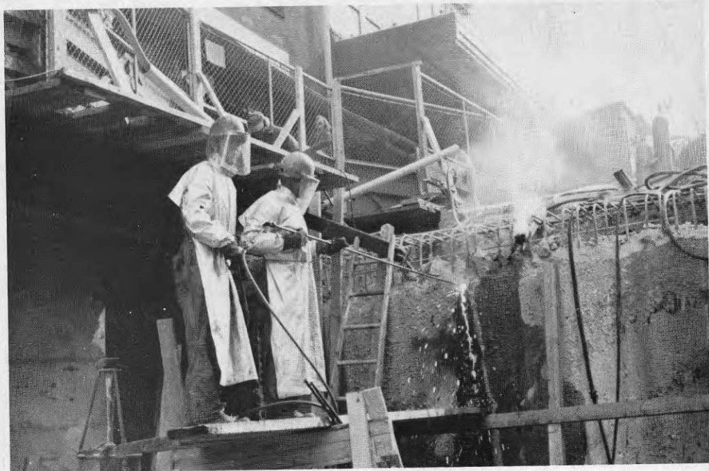
Figur 19. Lansning. Observera personalens omfattande, personliga skyddsutrustning.
