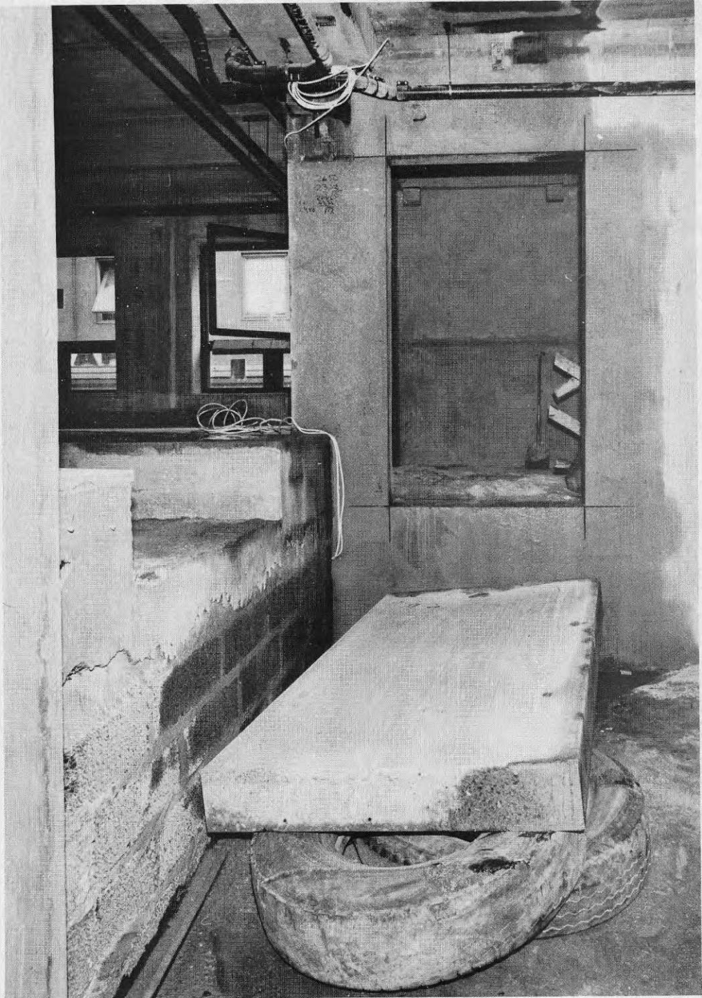
Figur 12. Arbetsresultat vid sågning. Observera de översågade hörnen.
