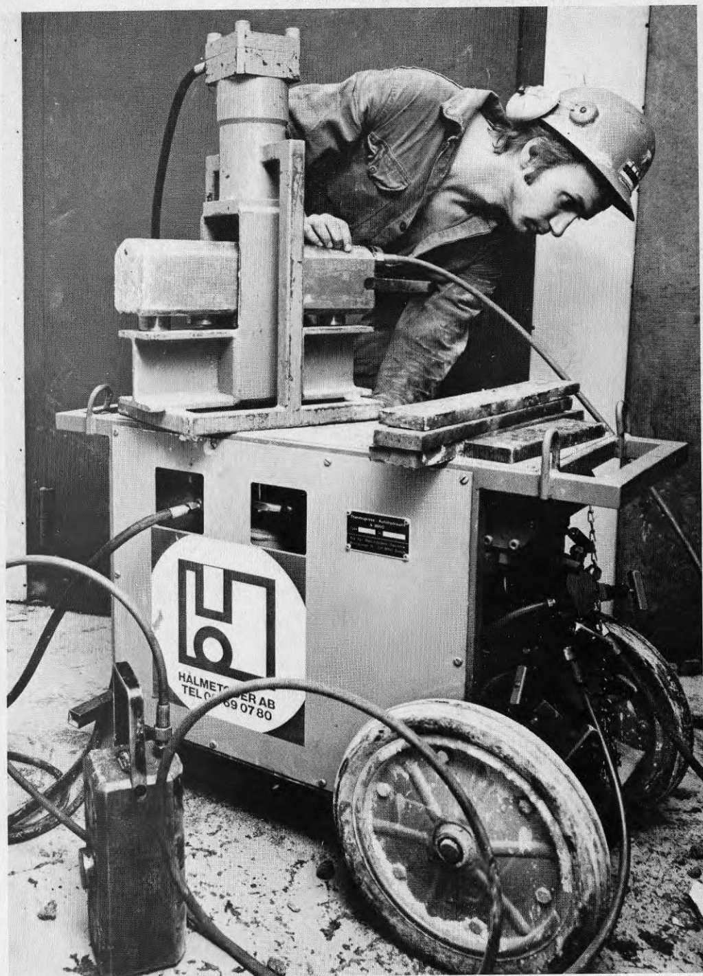
Figur 18 e) Kolvarna trycks tillbaka in i cylindern, med hjälp av en press som man här har ställt ovanpå hydraulaggregatet.
