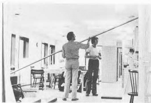
Figur 6.34 - 6.37 Väggflyttning i Borgvallastugan, Nacka.
