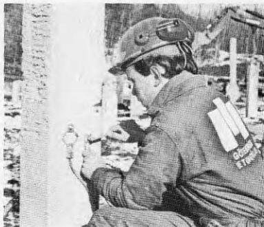
MONTERING AV ACCELEROMETER
