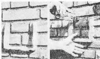
Kontroll av väggens täthet med hjälp av kitt och glasplatta.
