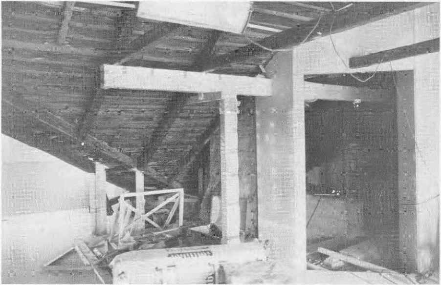
Avlastning av takstolar på balk och pelare intill språngtak- stol
