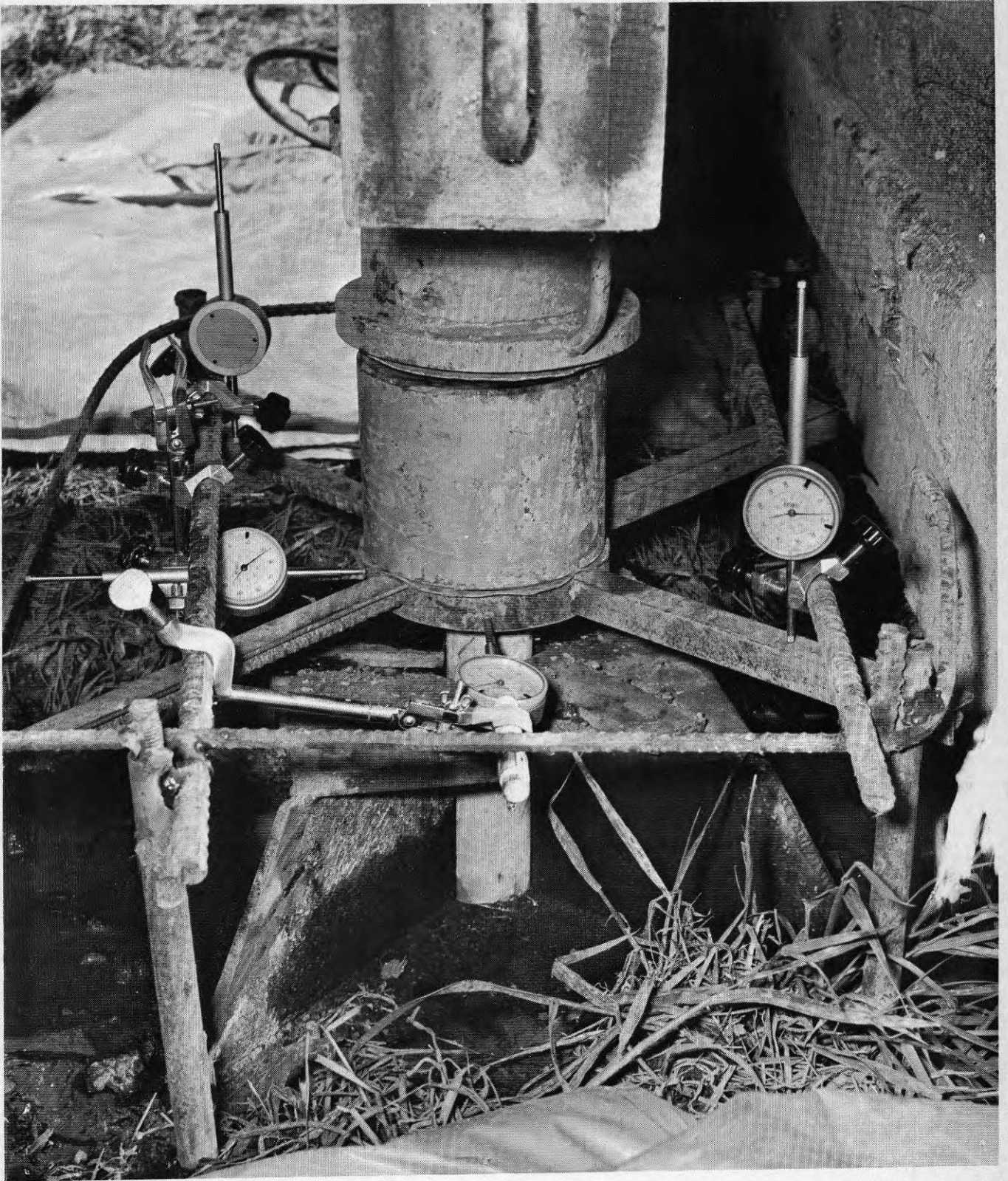
FIG 11 Mät- och styranordningar vid påltopp
