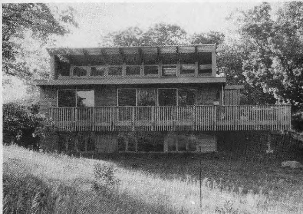
Tjänstebostad i Wild River State Park nära Minneapolis, USA. Husets väst- och nordsidor är jordskyddade liksom taket. Den nedre våningen är nedsänkt så att fönsterbrädningen befinner sig c:a 20 cm över markytan. Huset har det lägsta specifika energibehovet av de åtta som utvärderats inom Minnesota Housing Finance Agency's försöksprogram. (Arkitekt: McGuire, Engler and Davis, Stillwater, Minnesota).
