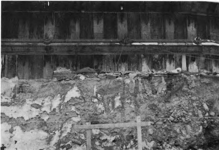
FIG. 3. Skärning genom moränen under spontspetsarna vid L. L. Brogatan ca 25 m från Västerlånggatan.
