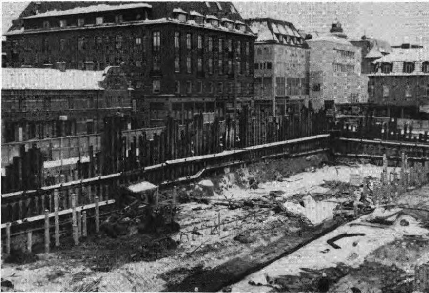
FIG. 2. Nordöstra delen av byggnadsområdet.
