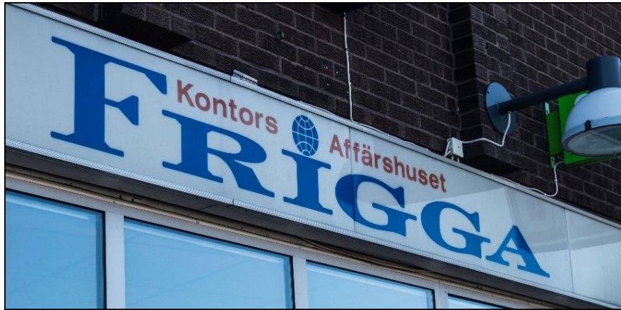
Figur 5, Skylt ovanför ingång till genomfartskorridor, fasad mot Ovanbroparkeringen
