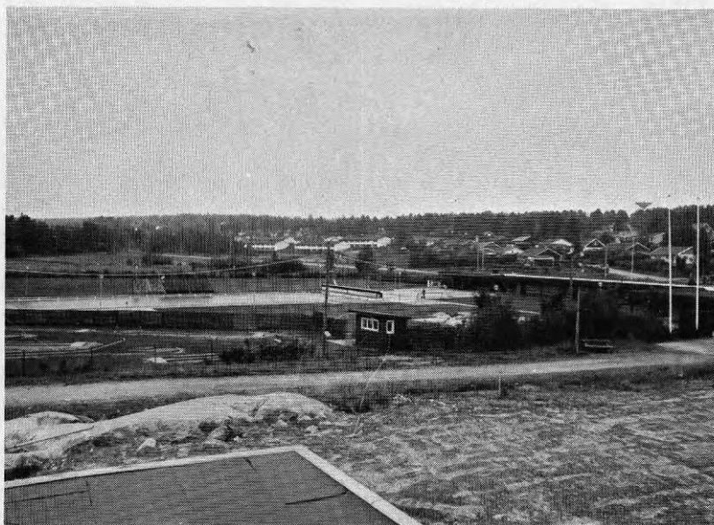
Figur 12. Bondsjöbadet. Bassänger till vänster och omklädningsbyggnad till höger.
