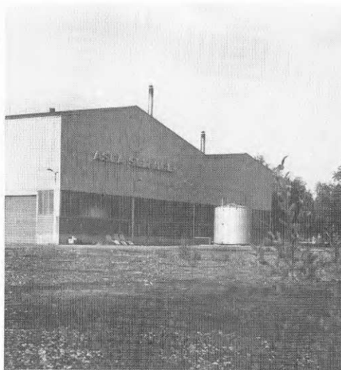
Bild 4.1 och 4.2 Spännarhyttans byggnader är delvis lämpade för återanvändning som industrilokaler
