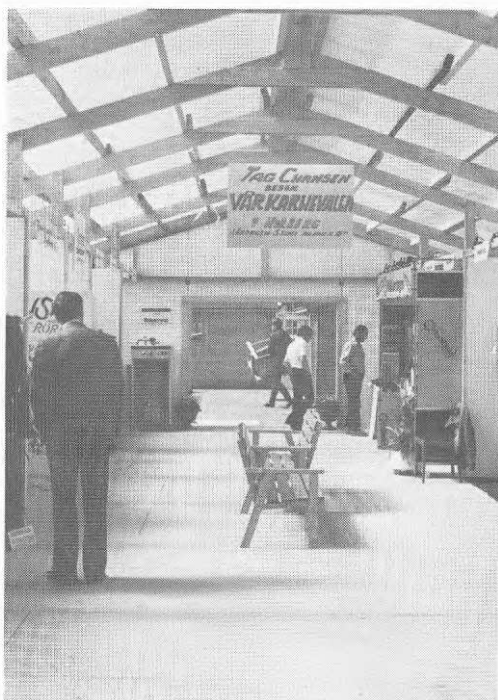
Bild 7.1 och 7.2 Utställningshallen byggdes i Norberg, monterades ner och fraktades till ut- ställningsområdet i Västerås för upp- montering
