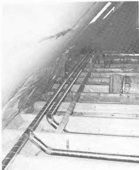
Figur 35. Kanaldragning i HUS-F.
