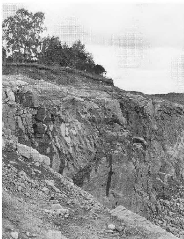
Figur 52. Bergschakt. På krönet syns den tunna jordtäckningen.
