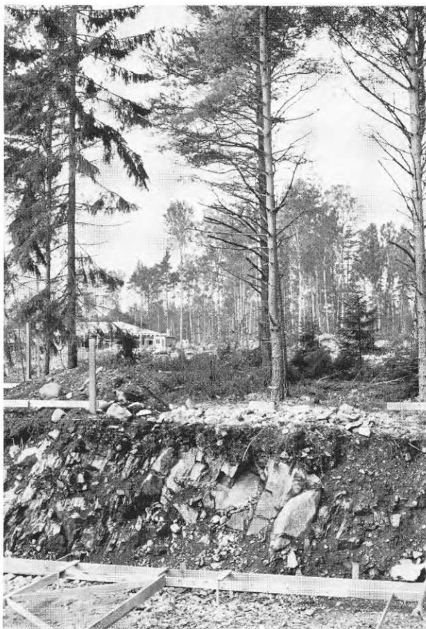
Figur 37. Schakt som visar moränens ringa mäktighet.
