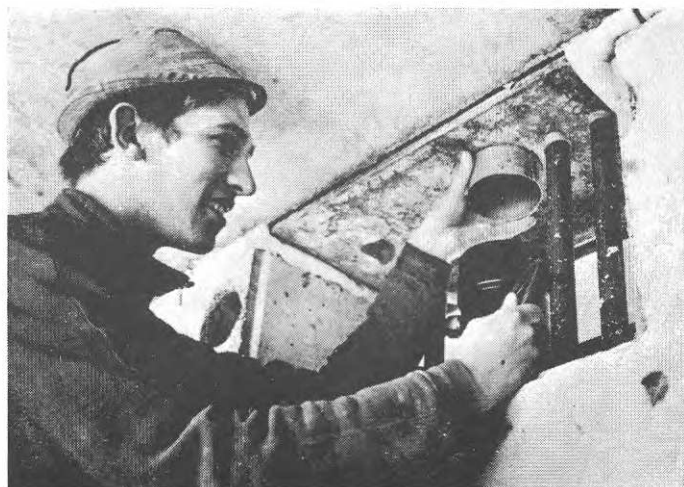
FIG. 29. Sedan stommontaget är avslutat sammankopplas ledningarna i Nils P Lundhs installationsvägg av rörmontörerna.
