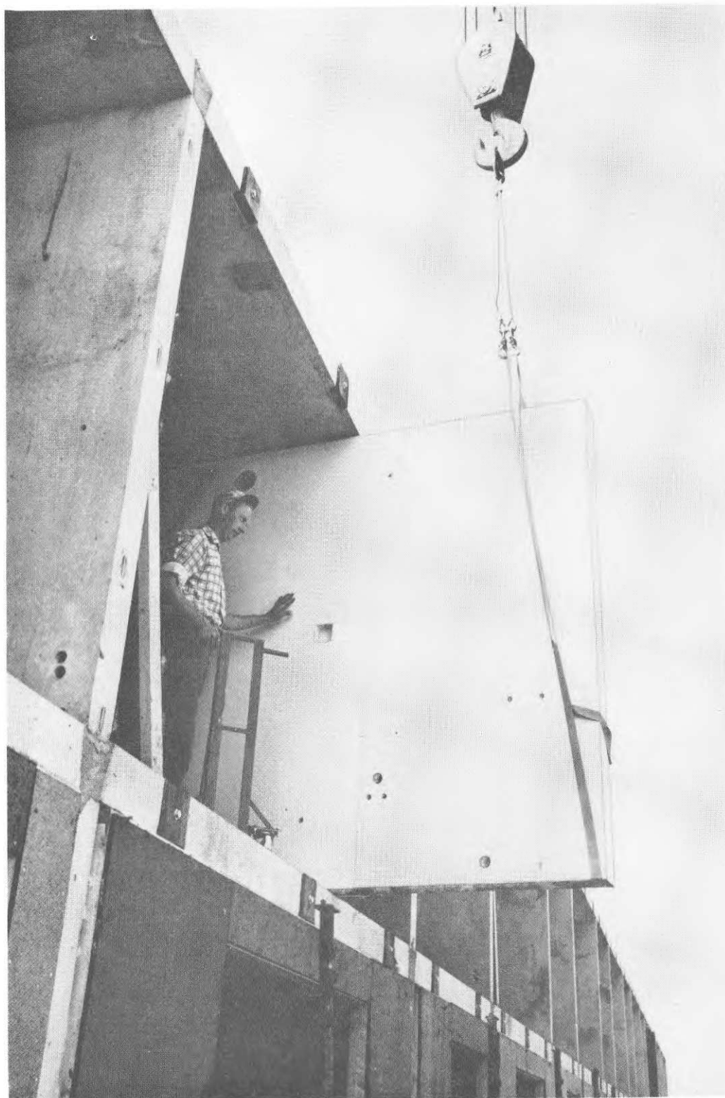
FIG. 27. Intransport på byggnadsplatsen av ISO-vägg från AB IFÖ-verken. På bilden syns även en av de två transportvagnar som används för att transportera väggen till sin plats i planet.
