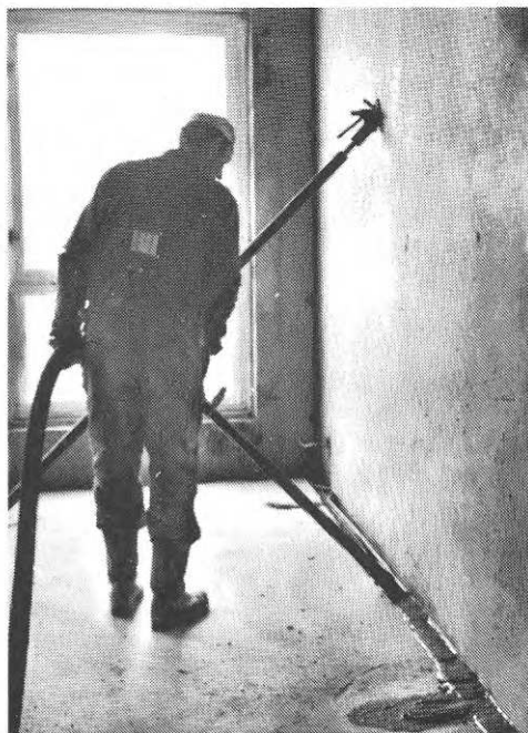
FIG. 7. Injektering av fog med el- och värmeledningar enligt FIG. 6.
