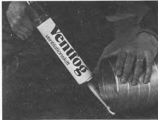
Figur 5.1 Ventilationskitt för tätning av plåtkanaler (R.E. Christenson AB)
