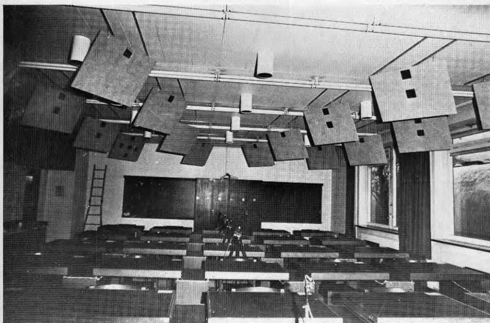
Sal V023 - med absorbenter, reflektorer placerade i taket.
