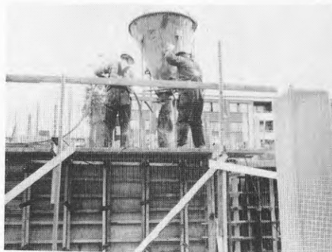
Bild 2.18 Betonggjutning
