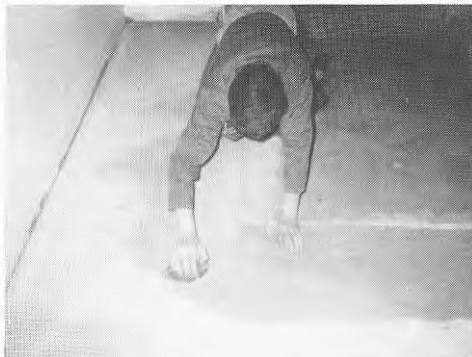
Bild 4.2 Slipning av betonggolv
