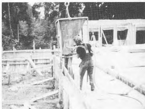
Bild 4.12 Gjutning på Kvinnligheten
