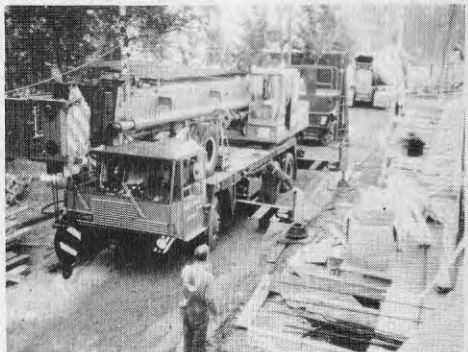
Bild 4.17 Kran och betongbilar...
