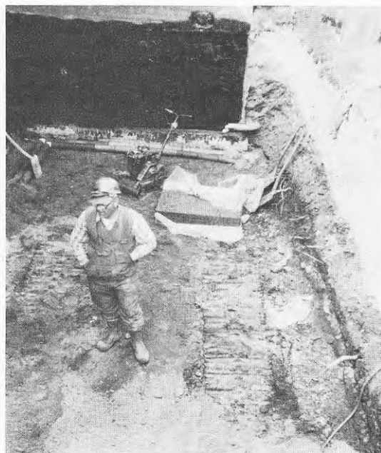
Figur 7.5. Fyllningsbyte.
