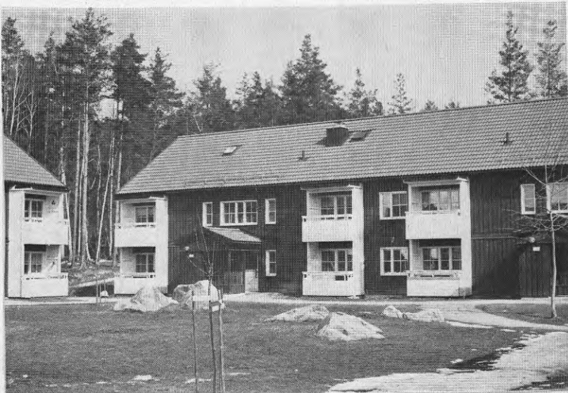
Husen i Bojsenburg innehåller vardera endast 10 till 19 lägenheter vilket klart försämrar lönsamheten för frånluftvärmepumpar.
