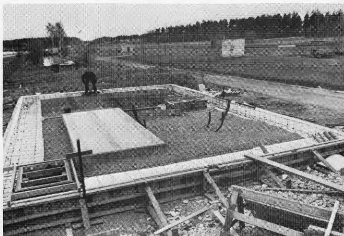
Fig 13. Värmepumpsbyggnad - sockelbalk samt fundament för värmepump
