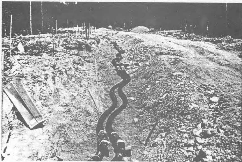
Bild 3.10. Utrullningsbar kulvert som utvecklats av Wirsbo Bruk AB och som provats vid Studsviks Energiteknik AB.
