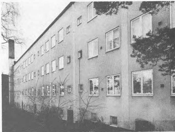
Figur 3.1 Ett av de 22 bostadshusen i Hägersten efter ombyggnad med fasadinstallation av nytt va-stamnät. Slitsarna har isolerats och täckts med plattor. (Tidskriften VVS nr 9, 1976)
