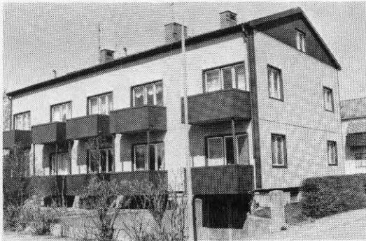
FIG. 13. En ny färgsättning som är helt främmande för byggnaden. Gavelspetsar, balkonger och hörn har markerats i avvikande färg. Plåtskarven på gaveln medför en kraftig skuggverkan. Genom den nya färgsättningen faller byggnadskroppen sönder på ett sätt som är främmande för miljön.
