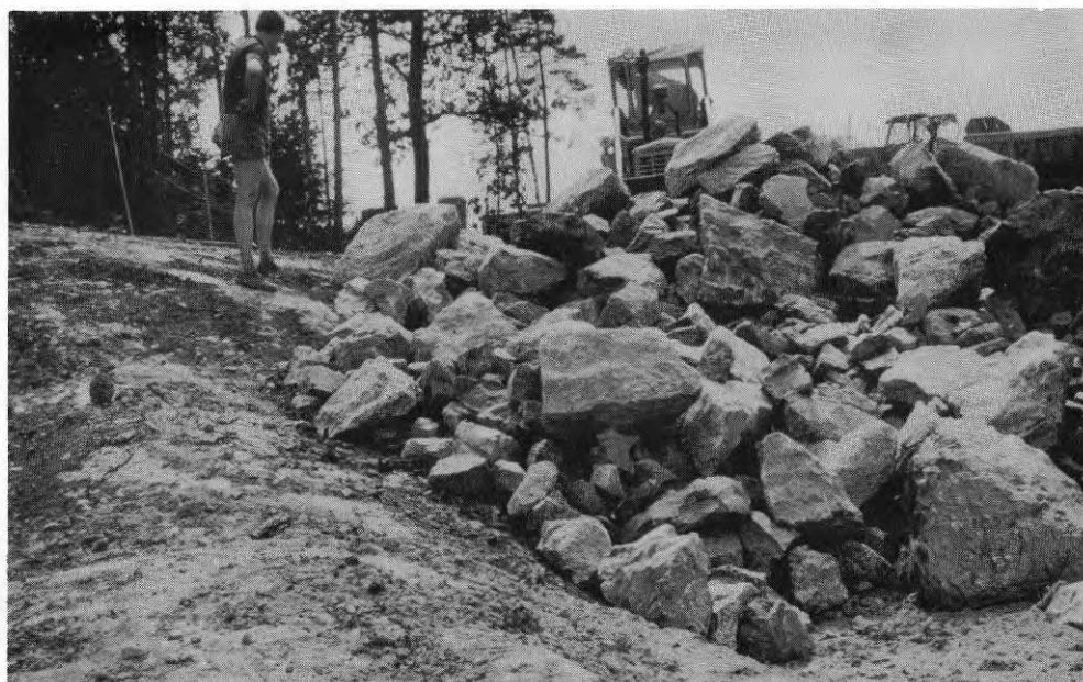
FIGUR 3. Utfyllning av sprängstensmassor.
