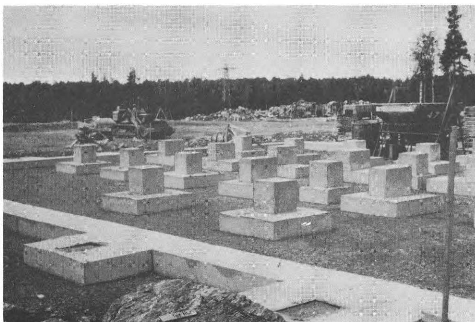
FIGUR 6. Färdiggjutna grundplattor.
