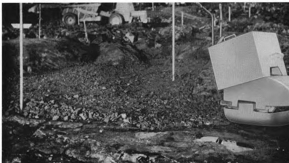
FIGUR 2. Alternativ avjämning av underlag för fyllning.
