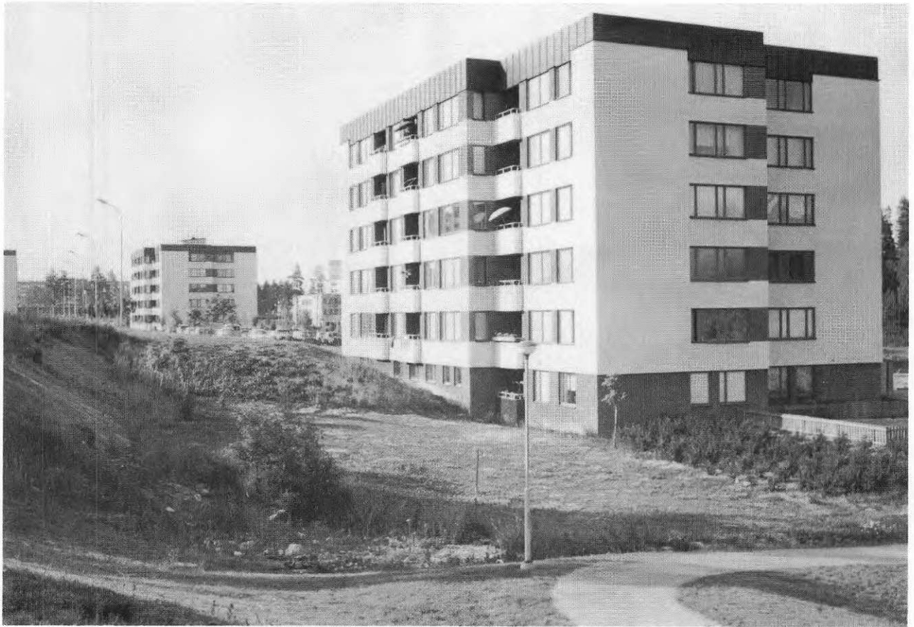
Bostadsstiftelsen Spåret, SKOGÅS, Trångsund. Närlokalen i bottenplanet mot gavelfasaden.
