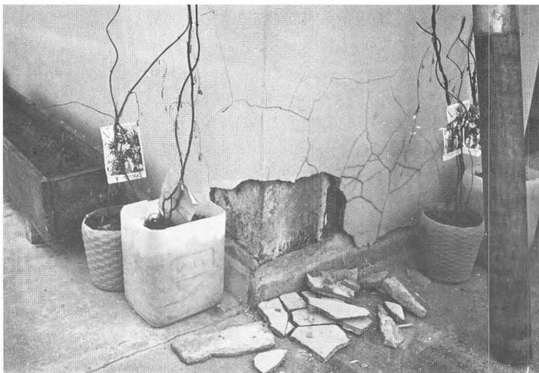
FIG. 38. Kristallbildning mellan putsen och underlaget har sprängt loss putsen.
