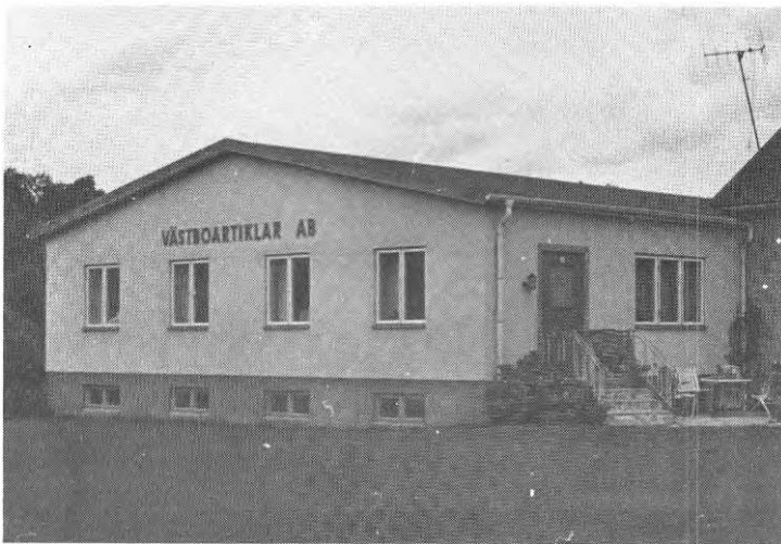
FIG. 20. Gavelfasad av lättbetong.
