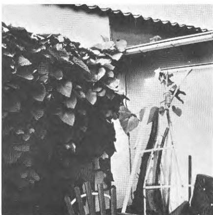
FIG. 13, 14. Garagets yttervägg fortsätter i en fristående mur. Genomgående spricka i begränsningen mellan garaget och muren. Olika grundläggningssätt kan misstänkas.
