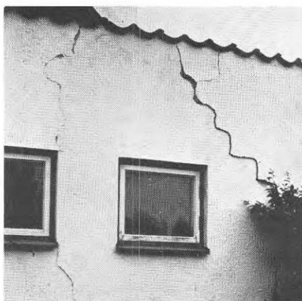
FIG. 13, 14. Garagets yttervägg fortsätter i en fristående mur. Genomgående spricka i begränsningen mellan garaget och muren. Olika grundläggningssätt kan misstänkas.
