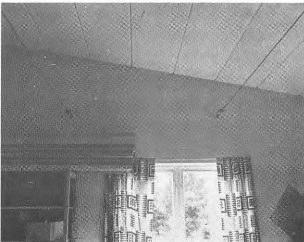
FIG. 21. Vägg belastas av wirar för belysningsarmaturer.
