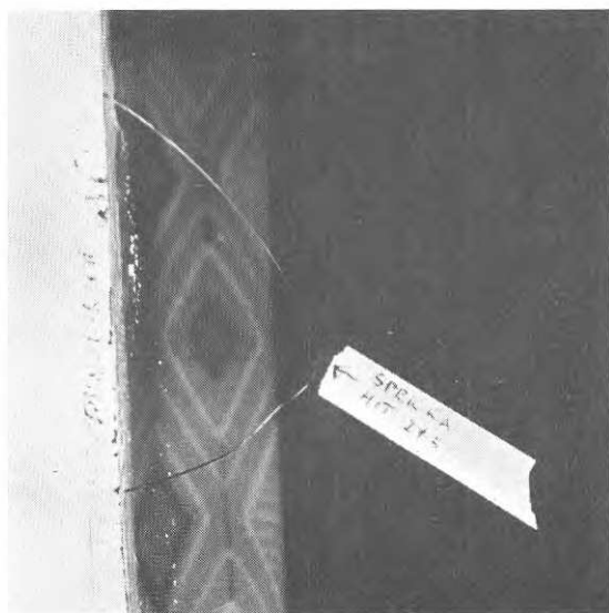
FIG. 122. Glasrutan i Nilssons hus där en gammal spricka förlängdes vid flygning 7:1.
