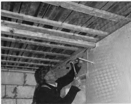
Bild 1: Undersida av bjälklag, med glespanel monterad.
