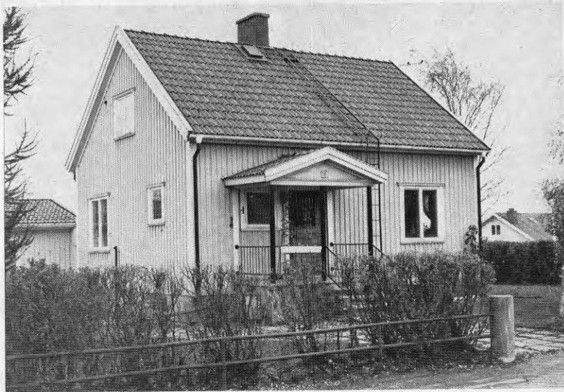
Figur 2.9. Grisbacka. Kvarteret Stenen 13. Stolpverks- hus, uppfört 1942 med bostadsanskaffningslån enligt typritning nr 13 vid Statens byggnadslånebyrå. Foto 1975.
