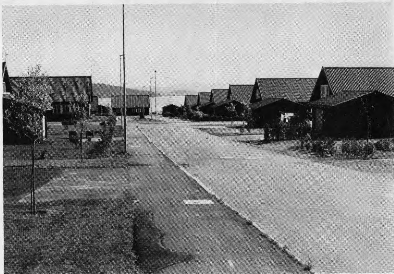
Figur 14.2. Tavelsjö. Centrum. Nya grupphus, uppförda 1973-1974 av ABV-Vägförbättringar i Umeå, vid den i byggnadsplanen utlagda vägen, sett från norr med utsikt över Tavelsjön. Foto 1976.
