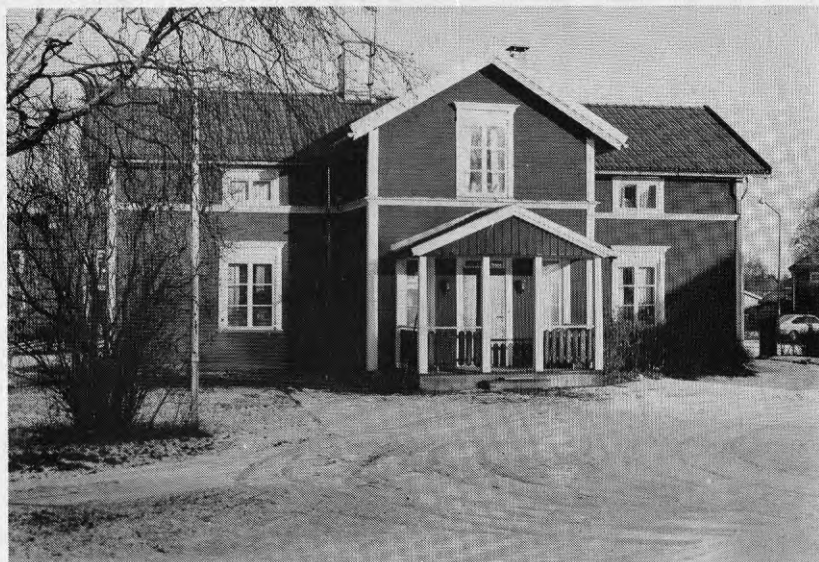
Figur 2.7. Grisbacka. Kvarteret Överåkern, stadsäga 45C i Backen. Parstuga, uppförd ca 1789, påbyggd med halv övervåning och tillbyggd med trapphus 1910-1915, försedd med farstukvist 1957. De ursprungligen vita fasaderna har omfärgats så att de nu är röda. Foto 1978.
