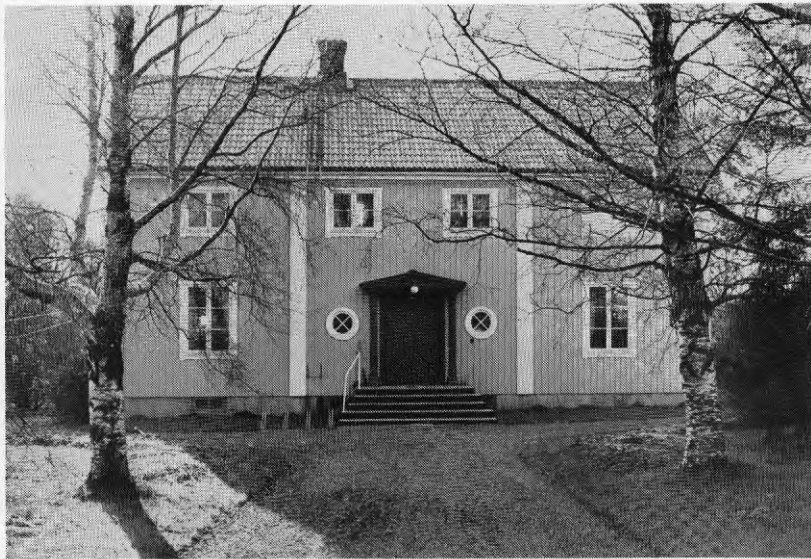
Figur 6.7. Grisbacka. Kvarteret Åkulla, stadsäga 24 i Backen. Stolpverkshus, uppfört 1931 enligt ritningar av folkskollärare och kantor Edvard Åberg, byggherre av bostadshus för eget bruk. Foto 1975.
