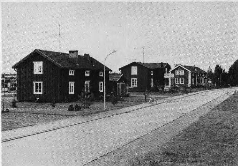
Figur 10.4. Sävar. Tre flyttade och i kvarteret Odlaren ombyggda parstugor. Längst t.h.: Sävar 66:3, parstuga med halv övervåning, uppförd 1836 i Holmträsk i Vindeln, flyttad och ombyggd med byggnadslov 1969. Foto 1976.
