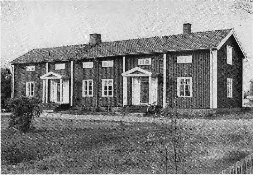
Figur 6.2. Grisbacka. Kvarteret Lagmannen, stadsäga 63 i Backen. Parstuga, uppförd ca 1785, förlängd ca 1814, påbyggd med halv övervåning, reparerad och försedd med farstukvistar 1938. Foto 1975.
