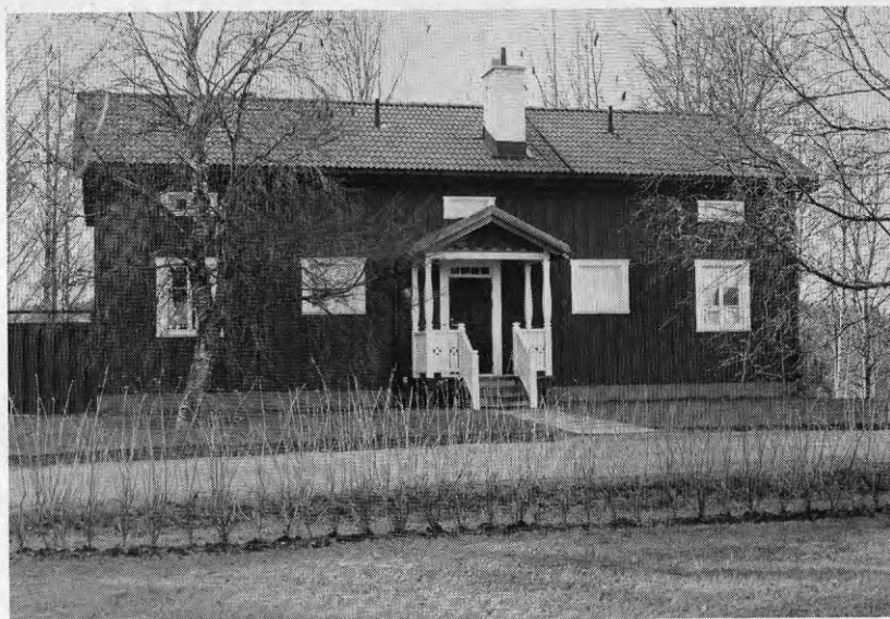
Figur 9.8. Brännland 5:57. Regelhus, uppfört med stads- hypotekslån och byggnadslov 1968 enligt ritningar av byggnadsingenjör Folke Brännström, byggherre av bostads- hus för eget bruk. Foto 1978.
