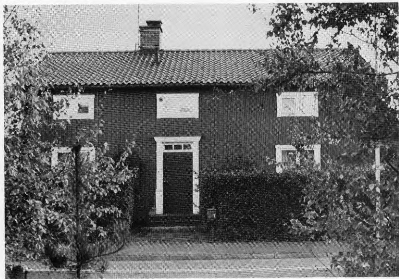
Figur 6.9. Grisbacka. Kvarteret Överåkern 3. Regelhus, uppfört med egnahemslån och byggnadslov 1957 enligt ritningar av Västerbottenskommunernas arkitekt- och byggnadskontor. Foto 1975.
