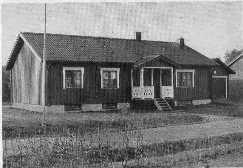
Figur 9.11. Brännland 5:68. Regelhus, uppfört med bostadslån och byggnadslov 1974 enligt ritningar av byggnadsingenjör Runar Jonsén, byggherre av bostadshus för eget bruk. Foto 1975.
