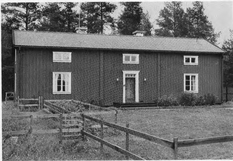
Figur 8.3. Kåddis 10.1. Parstuga med halv övervåning, uppförd 1866 i Kasamark i Umeå landsförsamling, flyttad och ombyggd med bostadslån för ombyggnad och byggnadslov 1964. Foto 1975.
