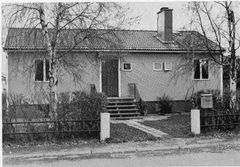
Figur 2.10. Grisbacka. Kvarteret Stenen 14. Regelhus, uppfört med egnahemslån och byggnadslov 1946 som system- hus (monteringshus) från Holmsunds ab enligt typritning av Knut Lindahl. Foto 1975.
