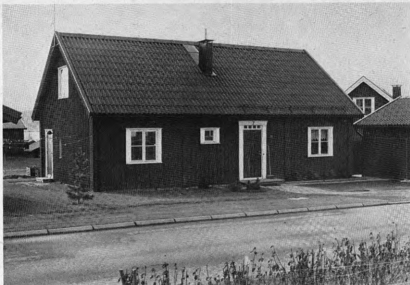
Figur 14.6. Tavelsjö. Näset. Regelhus, enplanshus med inredningsbar vind, uppfört med bostadslån och byggnadslov 1972 enligt ritningar av arkitekt SAR Torkel Sjöström, Umeå. Foto 1978.
