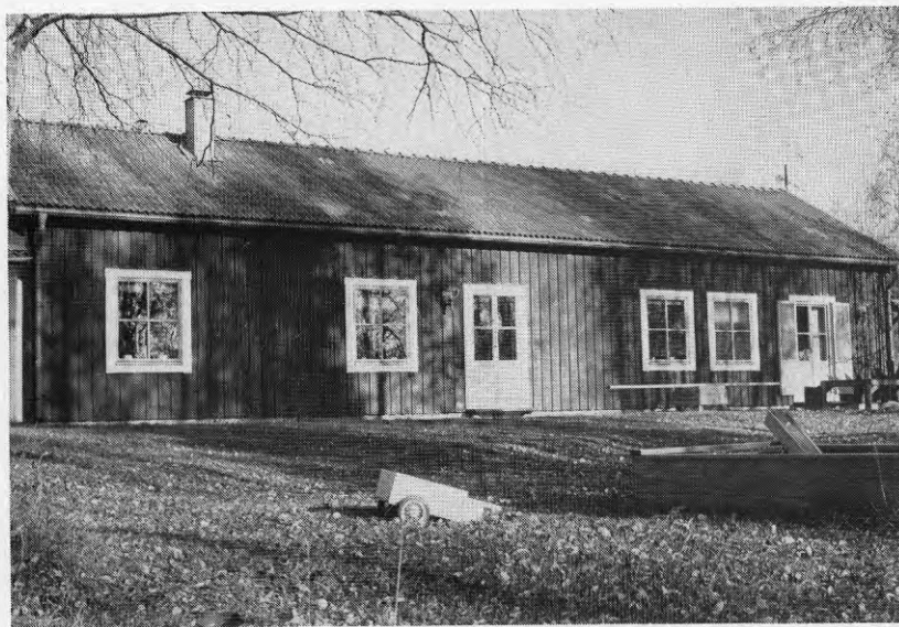
Figur 9.7. Brännland 5:52. Regelhus, uppfört med stads- hypotekslån och byggnadslov 1964 och 1966 enligt rit- ningar av arkitekt Bo Gustafson, byggherre av bostads- hus för eget bruk. Foto 1975.
