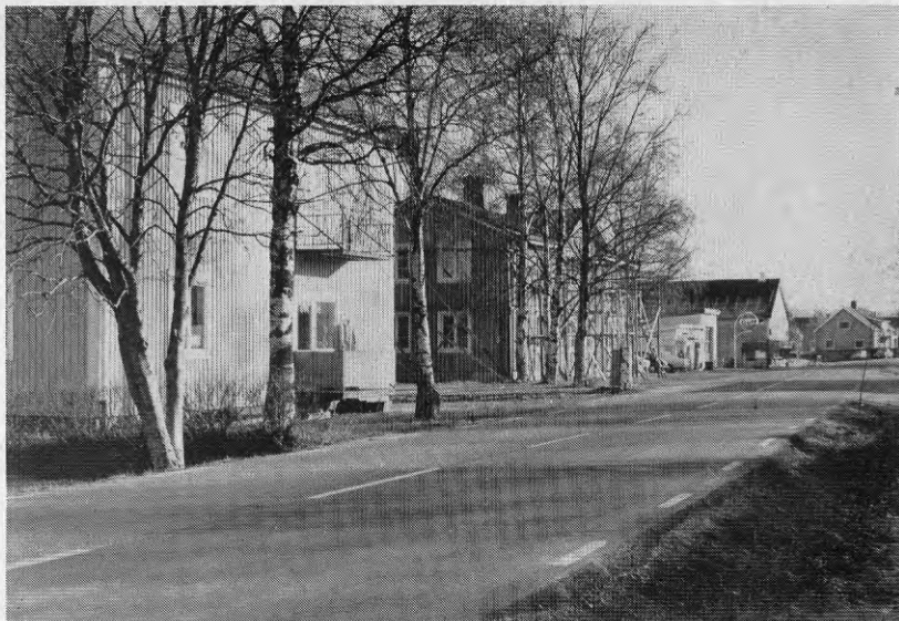
Figur 9.2. Brännland. Gamla landsvägen sedd från nordväst. Närmast t.v.: Brännland 5:11. Stolpverkshus, uppfört 1918 som disponents- och kassörsbostad i Brännlands nya träförädling ab, ombyggt 1965. Den symmetriska fasaden med dörr och veranda mitt på och ett fönster på var sida förändrades helt. Foto 1975.
