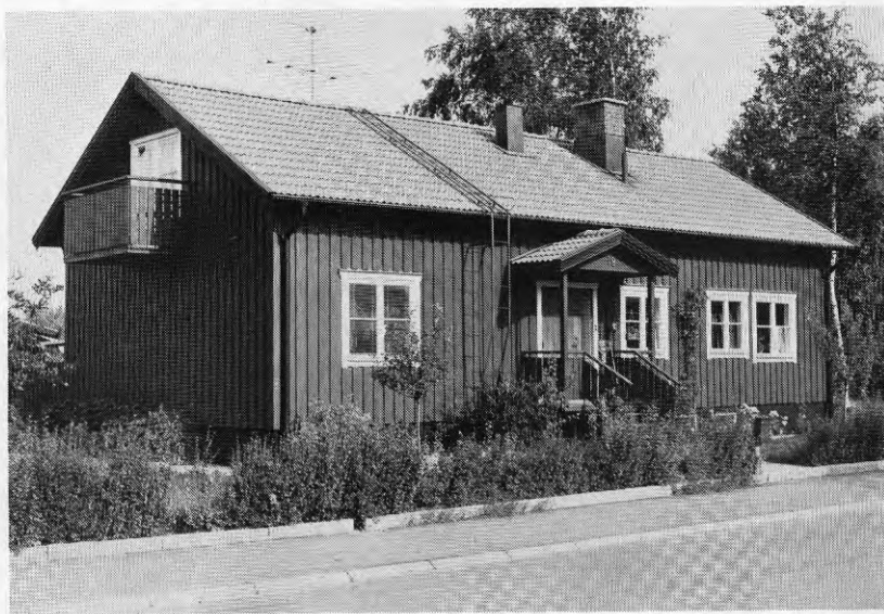
Figur 12.5. Böle. Kvarteret Kålroten 9. Regelhus, uppfört med byggnadslov 1969 enligt ritningar av Regelhus ab, Hudiksvall. Foto 1976.
