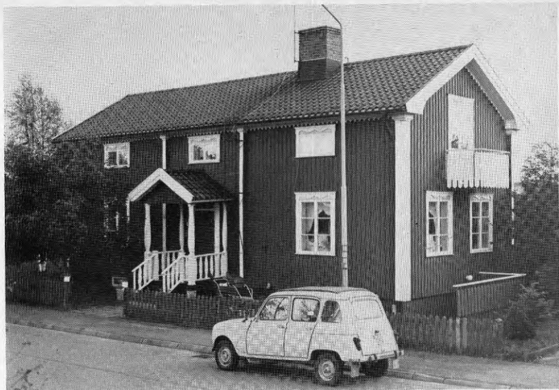
Figur 6.8. Grisbacka. Kvarteret Överåkern 2. Parstuga med halv övervåning, uppförd i Svarttjärn i Burträsk 1848, flyttad och ombyggd med egnahemslån för ombyggnad och byggnadslov 1957. Foto 1975.
