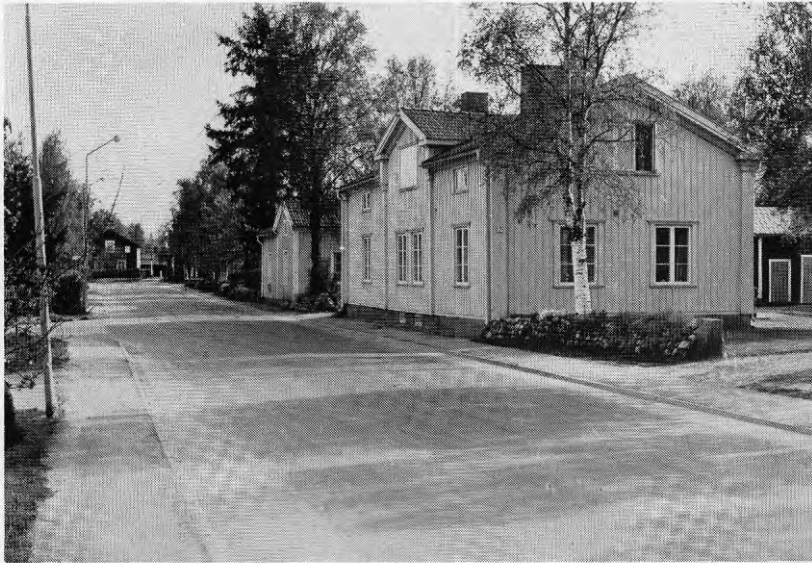
Figur 6.3. Grisbacka. Kvarnvägen sedd från norr. Kvarteret Raningen 4 och 5. Närmast t.h.: Förlängd halvkorsbyggnad med halv övervåning och trapphus, färdigställd 1888, reparerad 1946. Därefter: Enkelstuga, tillbyggd i vinkel 1935, reparerad 1945. Foto 1975.
