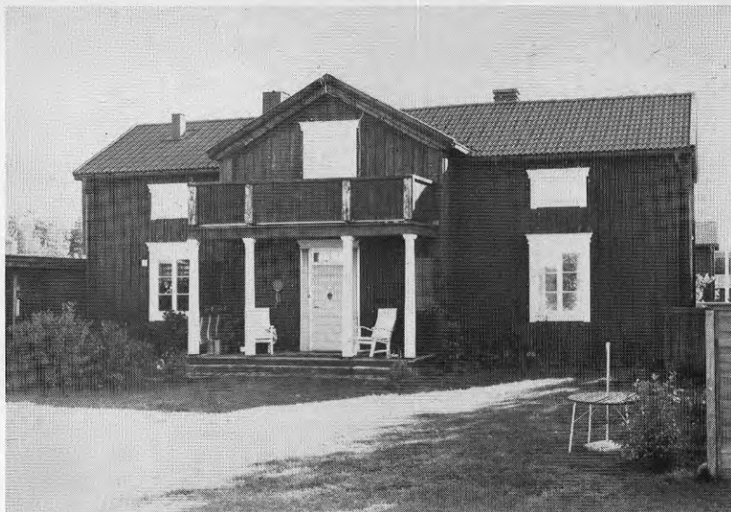
Figur 8.4. Kåddis 9:1. Parstuga med utbyggd farstu och halv övervåning, uppförd i Torrböle i Nordmaling, flyttad och ombyggd med bostadslån för ombyggnad och byggnadslov 1964. Foto 1975.
