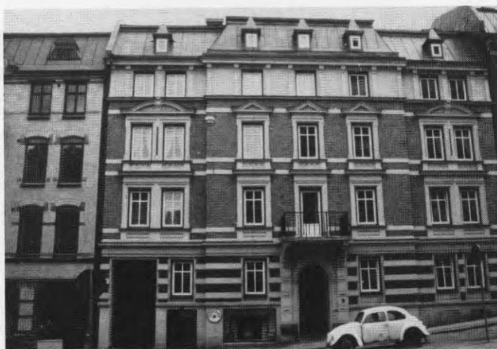
Bild 2b 80 år gammal fasad där endast tvättning varit av behovet vid byggnadens renovering.
