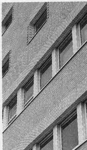
Fig 4.2 Förtillverkad fasadstensbalk över fönsterband
