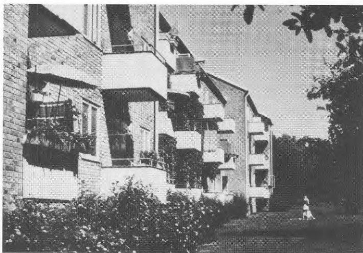
Bild 2a 40-talsbebyggelse utan fasadproblem.
