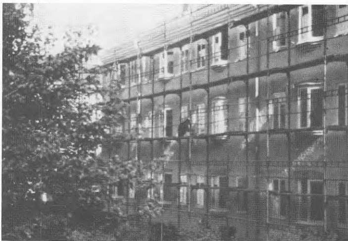
Bild 4 Flertalet putsfasader behöver kontinuerlig översyn. Ofta räcker det med ansiktslyftning genom omfärgning.
