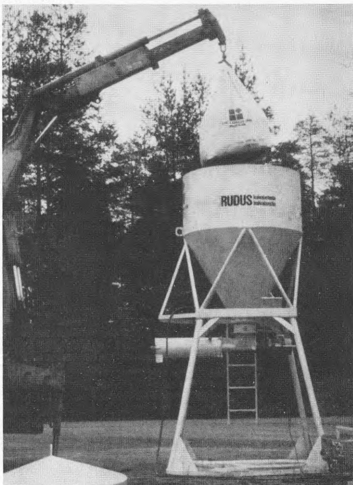
Storsäck och storsäcksilo med skrubblandare och vattenautomat på markytan.
