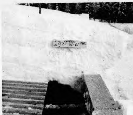
Figur 6.14 Ränna övertäckt med snö. Snön har smält i själva rännan. |39|.
