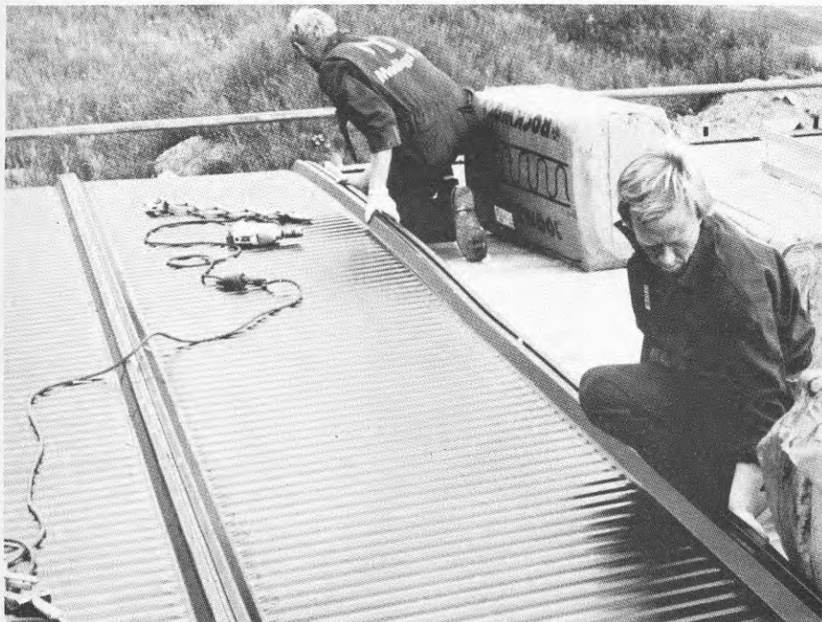
Figur 1.3 Utläggning av Plannjas TOP7-plåt.
