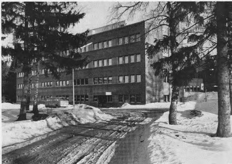
Figur 2.1 Telekomponentkontoret på FFV Underhåll i Arboga.
