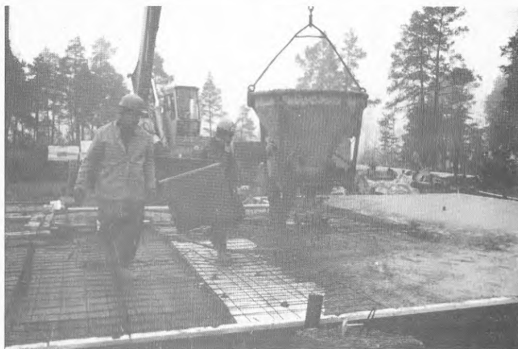
Bild 20. Kran och baskgjutning med laserytavjämning
