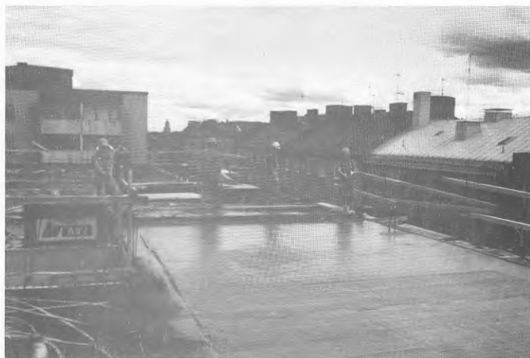
Bild 21. Ytavjämning med vibrobrygga
