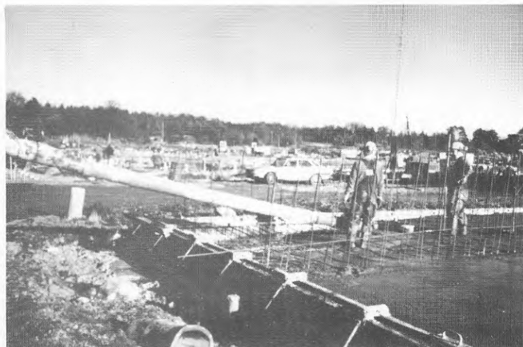
Bild 18. Slasrörsgjutning med bra flytbetong
