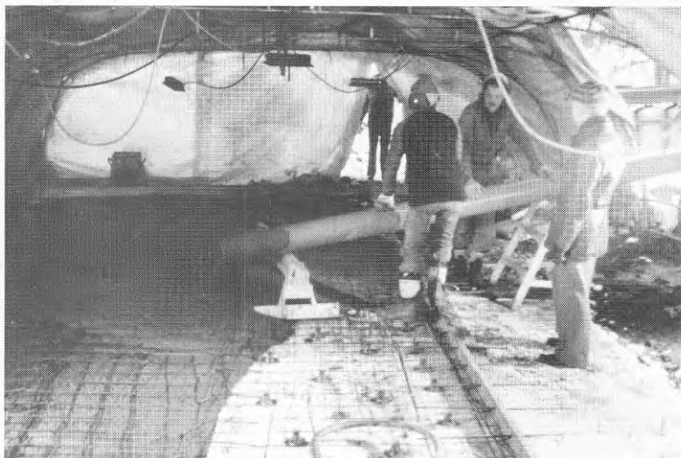
Bild 3. Slasröret uppstöttat på två träbockar
