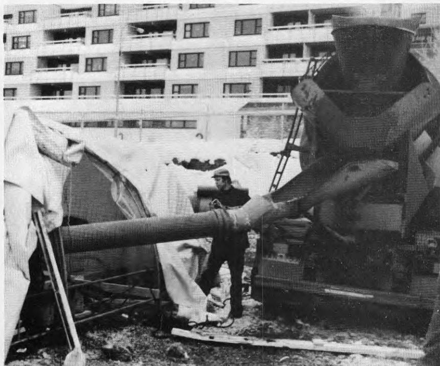
Bild 1. Anslutning av slasröret till roterbil
