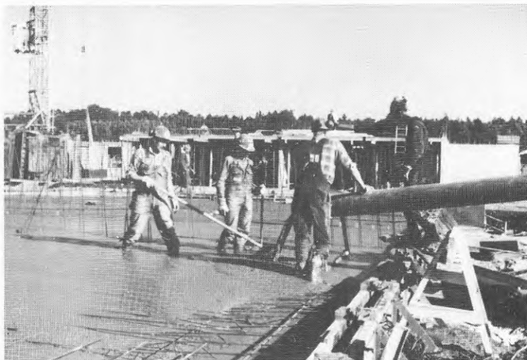
Bild 13. Mottagning av flytbetong och fördelning med raka
