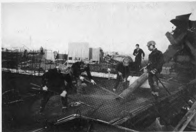
Bild 14. Fördelningsarbetet vid dålig flytbetong
