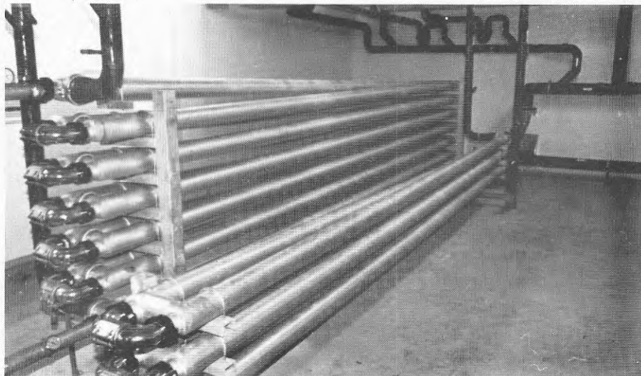
Figur 4. Värmeväxlare för återvinning av värme ur avloppsvatten. Till vänster värmeväxlare för spillvatten och till höger för köksavlopp.
