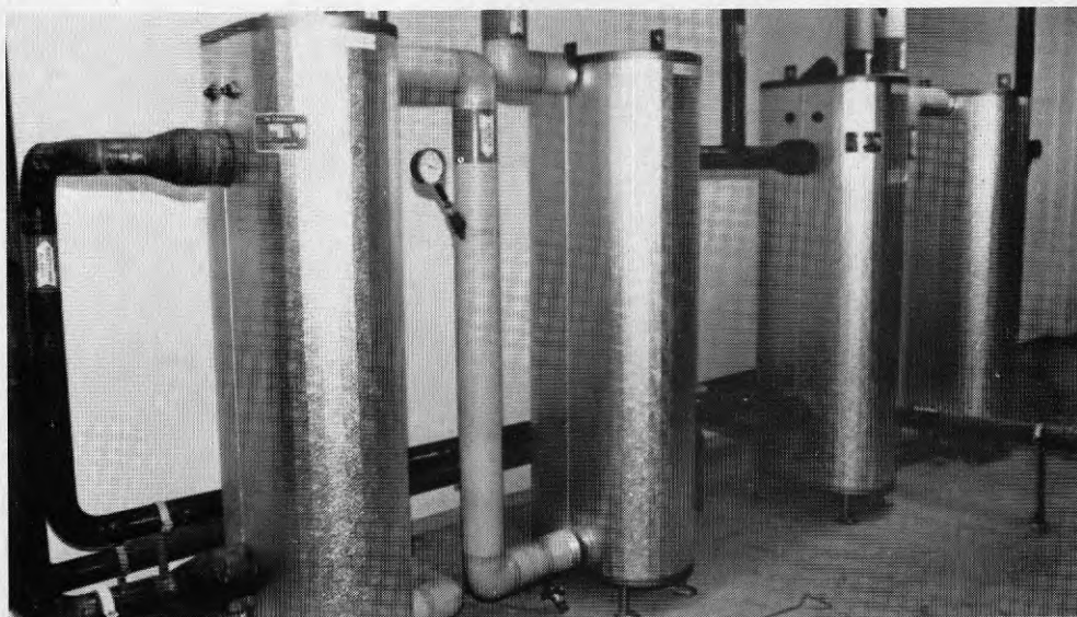
Figur 7. Foto av värmväxlare mellan servicevatten och mellankrets.
