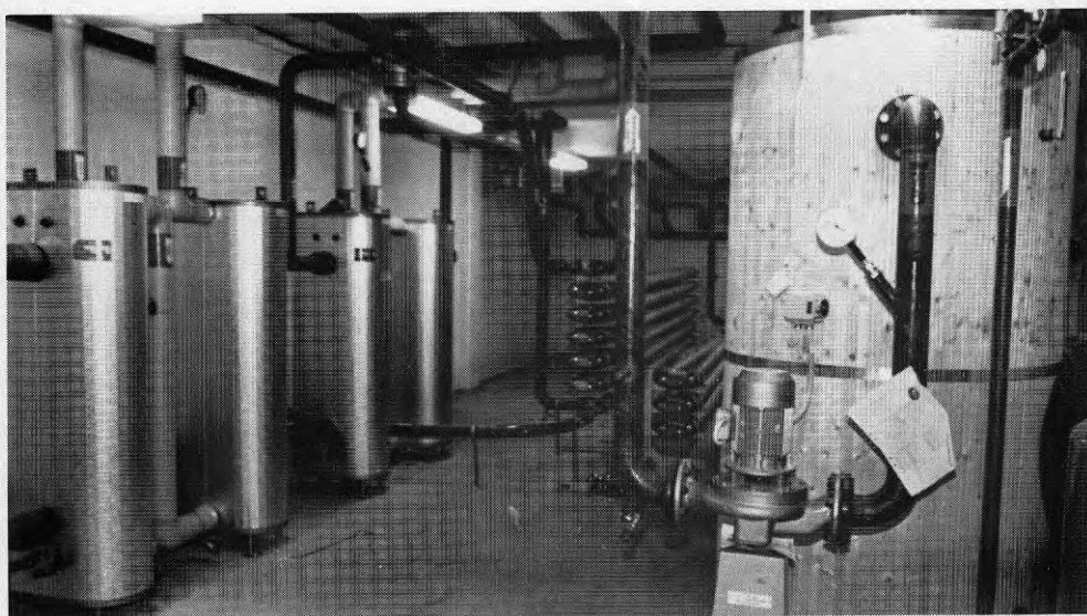
Figur 7. Foto av värmväxlare mellan servicevatten och mellankrets.
