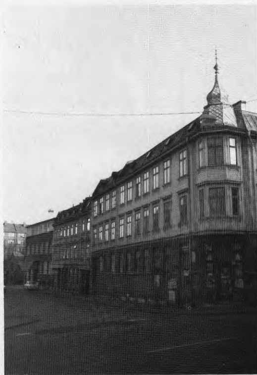
Bild 5. Landshövdingehuset vid Såggatan i stadsdelen Majorna
