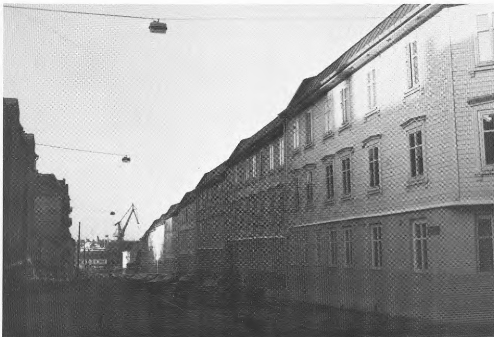
Bild 29. Kv Kolumbus i stadsdelen Majorna, nu helt ombyggt.
