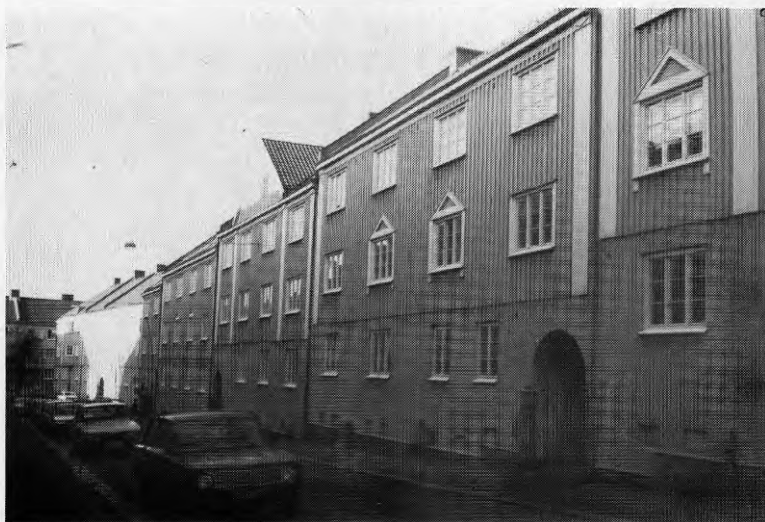
Bild 14. Det ombyggda kv Kungsljuset i stadsdelen Kungsladugård.
