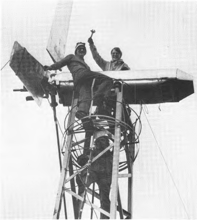
Justeringsarbete på Teravinds första vindkraftverk, 10 kW-aggregatet.
