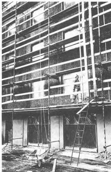
tm-metoden Isolerplattor monterade
