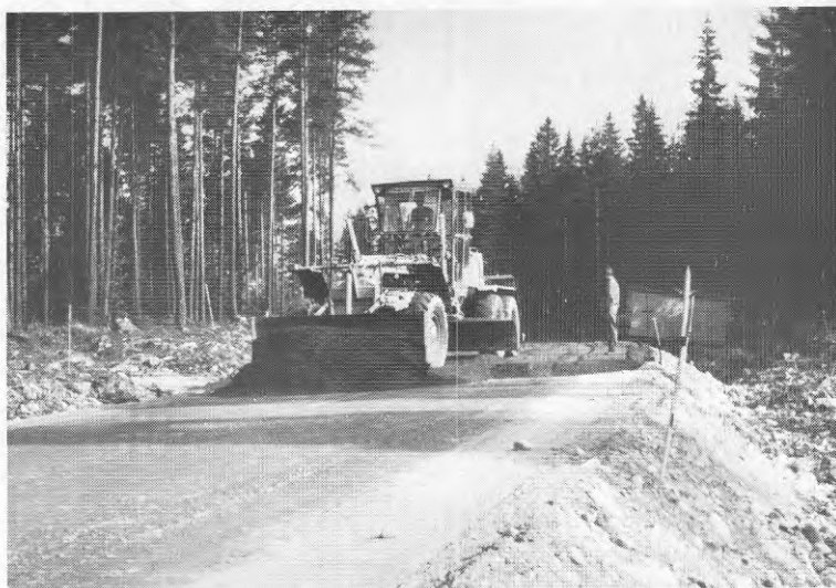
Fig 6. Utläggning av CG med hyvel.
