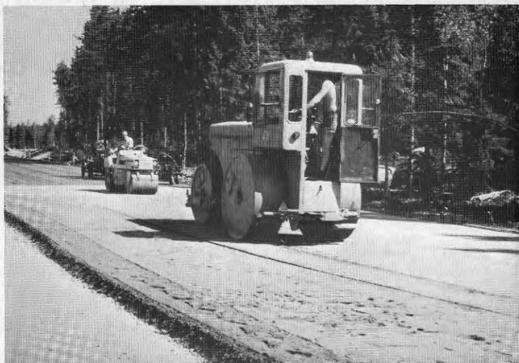
Fig 8. Packning med 10 tons slätvält (Svedala) och med vibrerande vält (Dynapac CG12)
