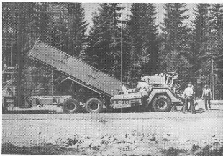
Fig 7. Utläggning av CG med asfaltläggare.
