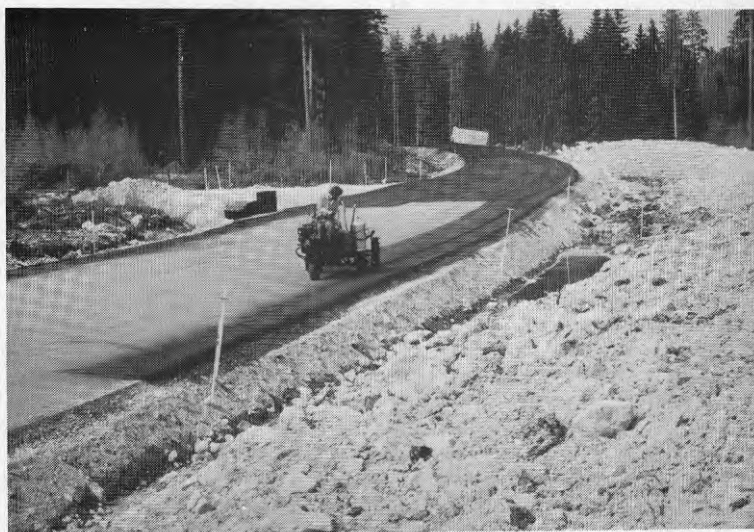
Fig 9. Försegling av CG-ytan utförs med s k klistermoped.
