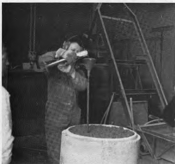
Figur 3 Tillsättning av flytmedel innan vibrering
