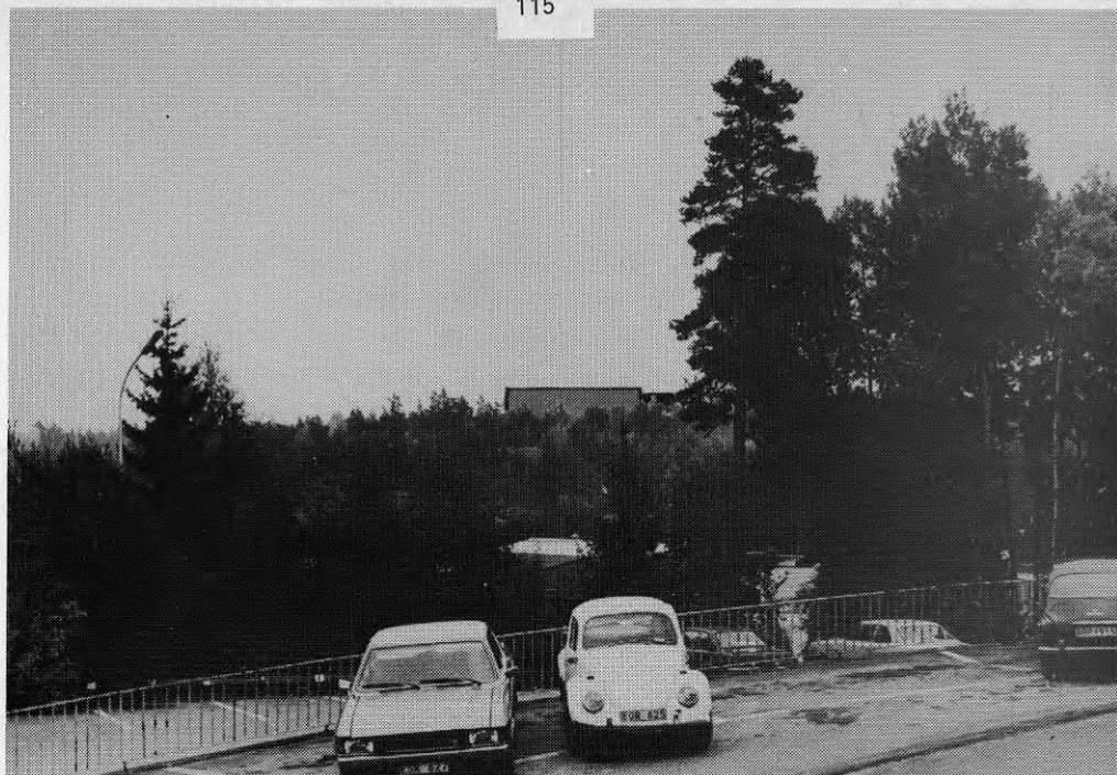
Fig. 6.26 Foto från Norrtuna. Ståltank och solfångare syns.
