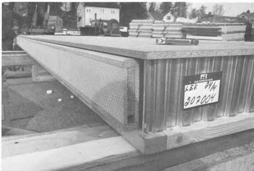
Figur 20 För tätning mellan bjälklagselementen användes speciella regler uppbyggda av spånskivelister med mellanliggande porösa träfiberskivor.
