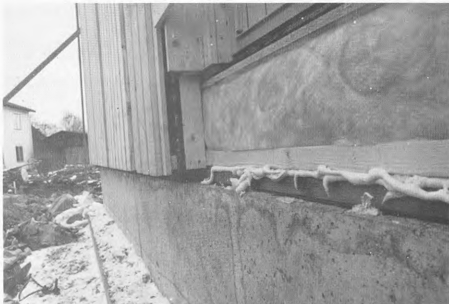
Figur 23 Fogtätning mellan bjälklagselement och syll.
