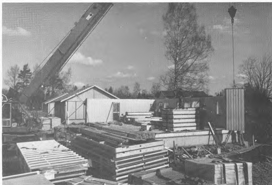
Figur 24 Överbyggnad under färdigställande.
