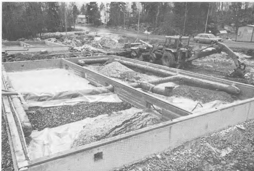
Figur 15 Grund för hus 3. Visar också kanalsystem för varmluftsdistribution.
