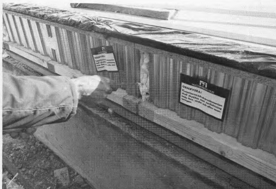
Figur 22 Fogtätning utförs i fog mellan element.
