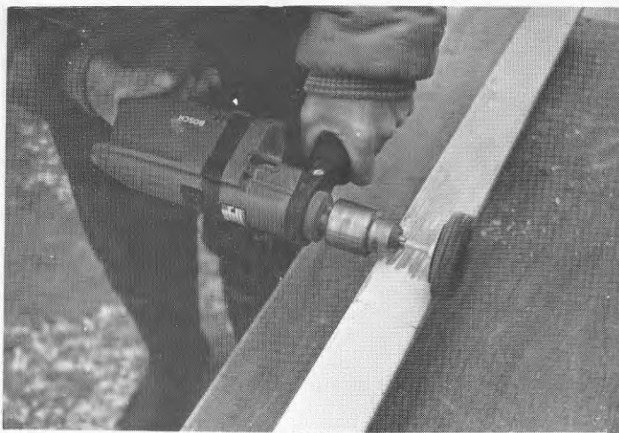
Fig. 2:1 Färgborttagning med slipskiva (Alkyd)
