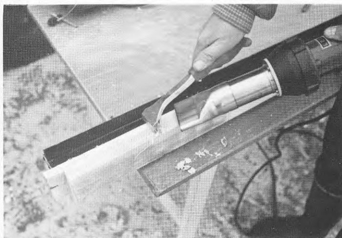
Fig. 2:2 Färgborttagning med hetluft (Alkyd)
