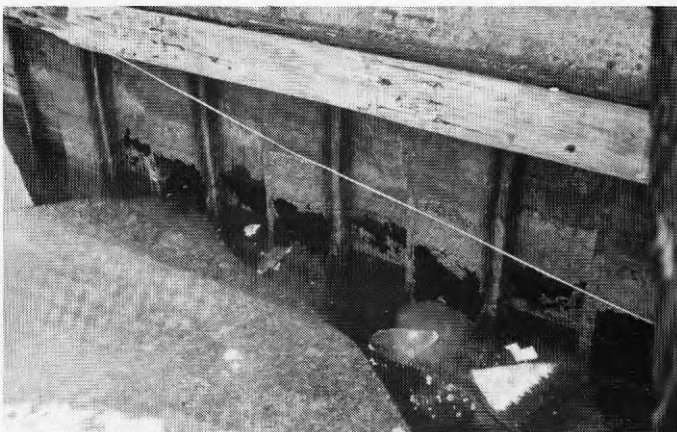
Figur 4.9 Stockholm, Strandvägen Genomrostad stålspont fotograferad vid lågvatten
