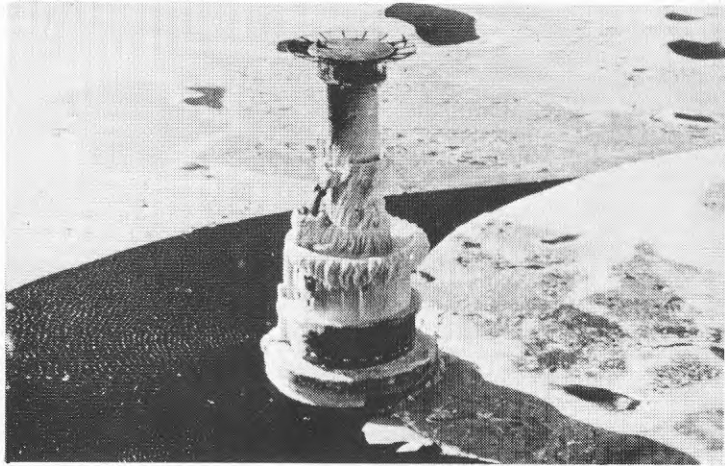
Figur 1.3 Grundkallens fyr under ispåverkan
