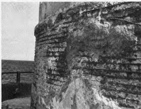
Figur 4.8 Kassunfyr, södra Östersjön Platsgjutet torn
