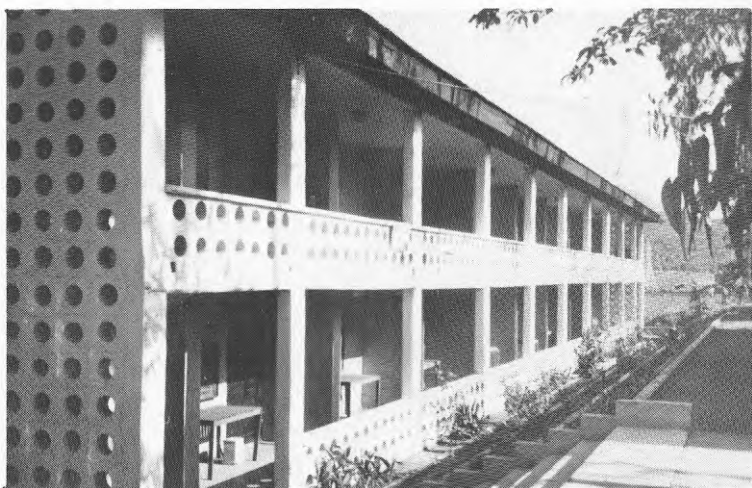
Ny ungarlänga med 16 lägenheter har byggts till i Uong Bi.
