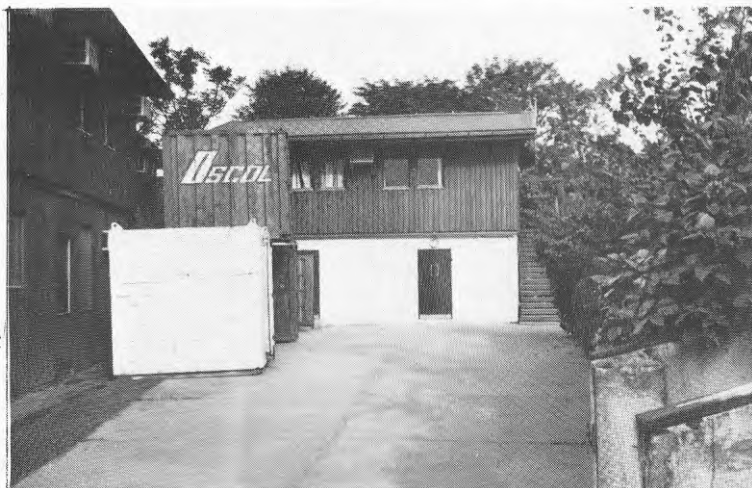
Nybyggnad av butik och samlingslokal på Hanoicampen. I förgrunden con- tainers som till- fälliga förråd.
