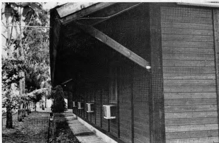
Stormförstärkning av takutsprång på husen i Uong Bi.
