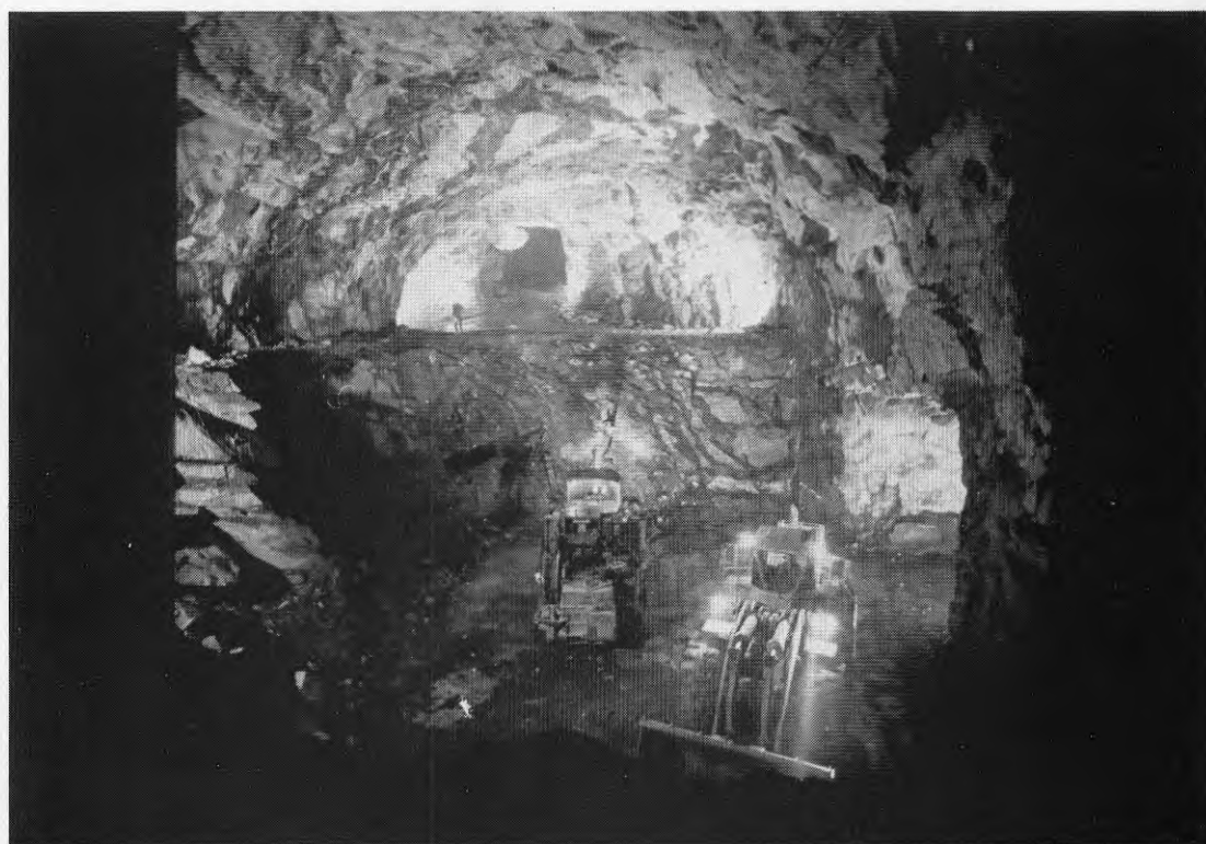
Figur 2:15 Takgalleri utsprängt. Arbeten med pall 1 pågår.
