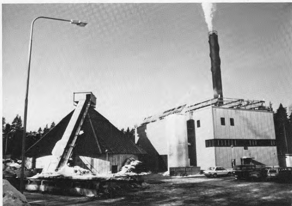
Figur 1:9 Knivstaverket med solfångarinstallation på taket.
