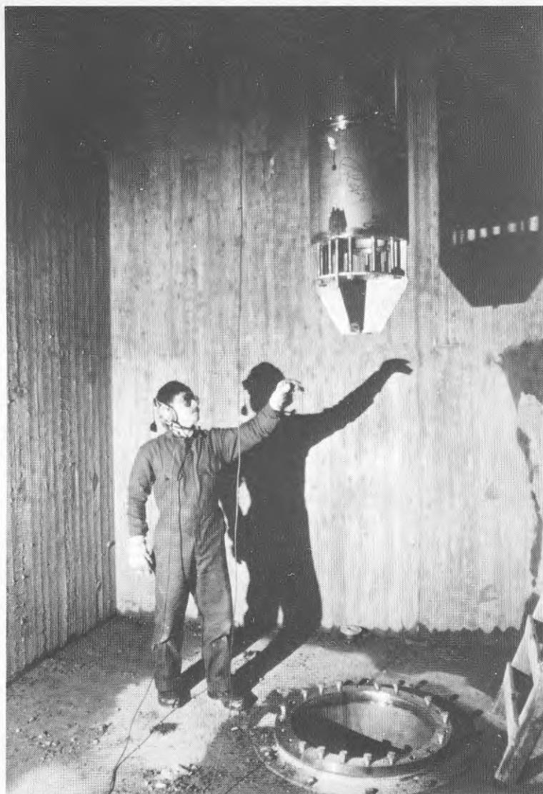
Figur 2:24 Montering av in- och utmatningsrör
