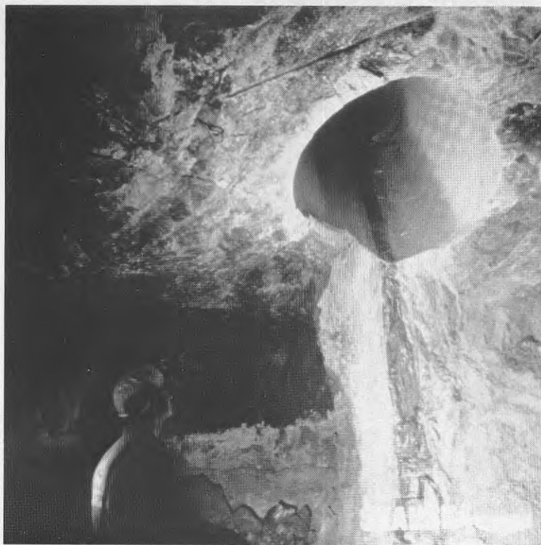
Figur 2:21 Fullortsborrat hål \varnothing 1 m
