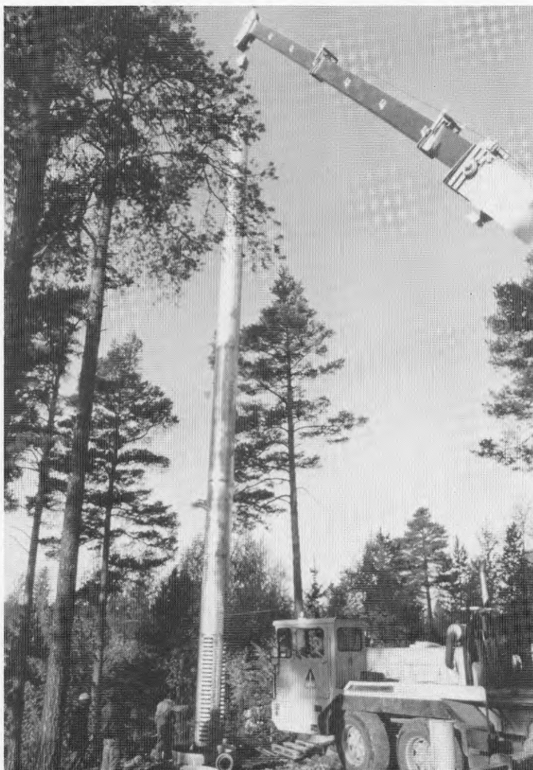
Figur 2:23 Montering av in- och utmatningsrör
