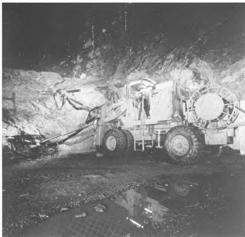
Figur 2:16 Borrhning för sprängning i pall 1.
