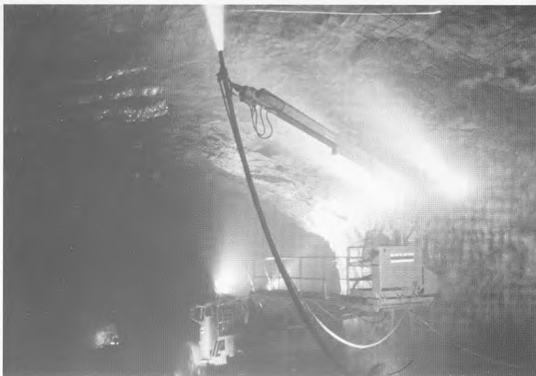
Figur 2:19 Förstärkning av bergrumstak med sprutbetong.
