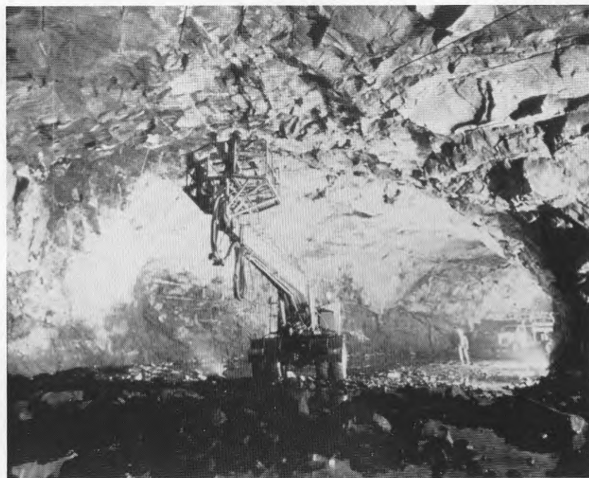
Figur 2:18 Skrotning och bultning i tak
